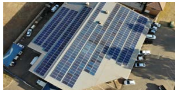
Installation de panneaux solaires sur un site de Zalawi Whitehorse
