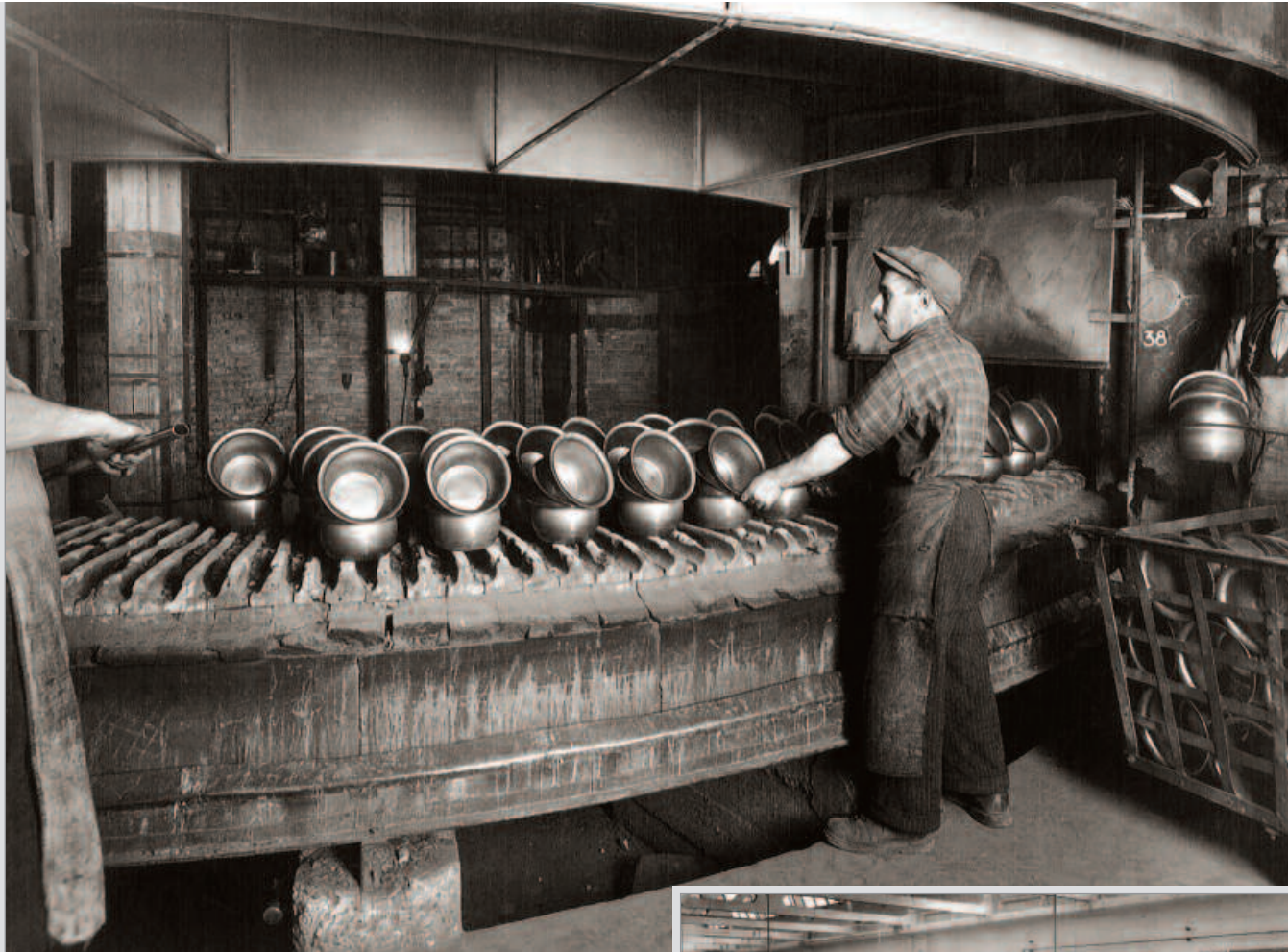
Il grande forno a suola girevole, destinato a ricuocere i pezzi stampati (1928).
