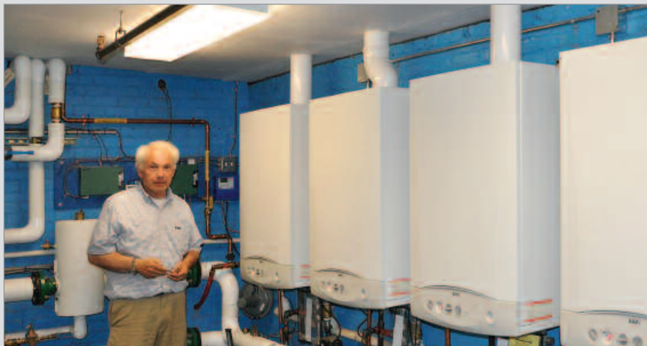
Da sinistra verso destra Installazione di caldaie Baxi ad alta potenza presso la Biddeford Ice Arena nel Maine (2005).
