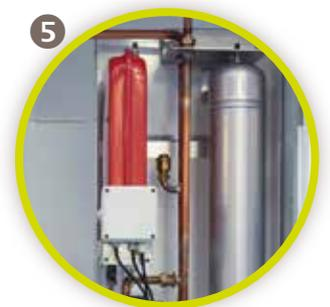
Vaso di espansione e modulo idraulico per Acqua Più 150
