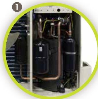
Compressore twin rotary DC inverter completo di protezione termica interna e resistenza carter, è montato su gommini antivibranti e avvolto su cuffia isolante per ridurre la trasmissione di rumori e vibrazioni dovute al funzionamento.
