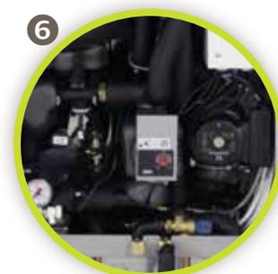
Pompa di circolazione ad alta efficienza a modulazione totale (la pompa è maggiorata nelle versioni con pdc AWHP MR 11 e HPS 6/8/12 kw)
