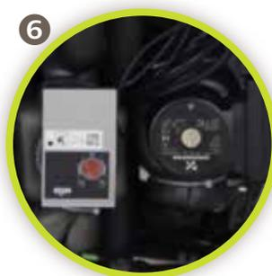
Pompa di circolazione ad alta efficienza a modulazione totale (la pompa è maggiorata nelle versioni con pdc AWHP MR 11 e HPS 6/8/12 kW) e pompa scambiatore gas refrigerante
