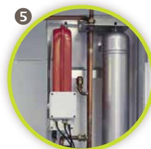
Vaso di espansione e modulo idraulico per Acqua Più 150
