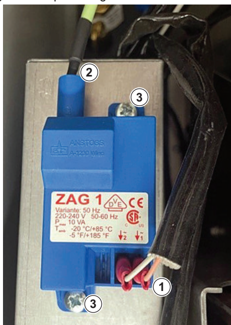
Fig.27 Dépose du générateur d'étincelle
