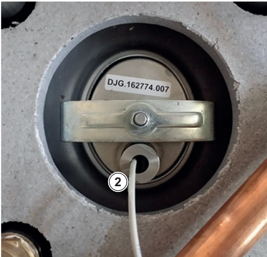
Afb.19 Verwijderen van de sensor
