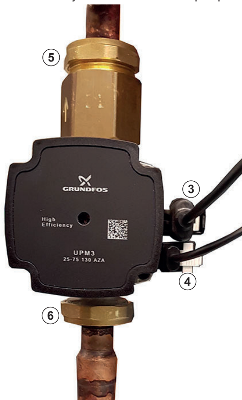
Afb.52 Verwijderen van de circulatiepomp
