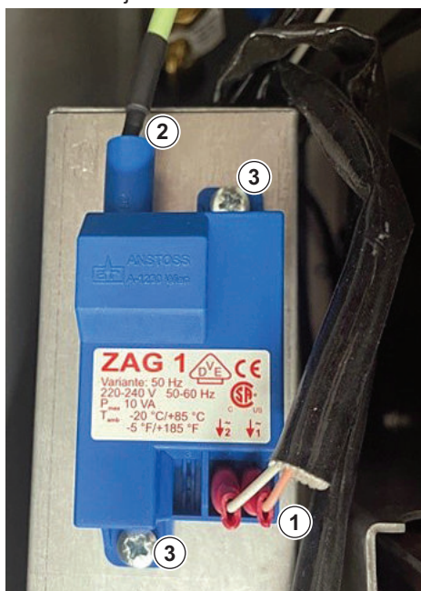
Afb.27 Verwijderen van de ontstektrafo
