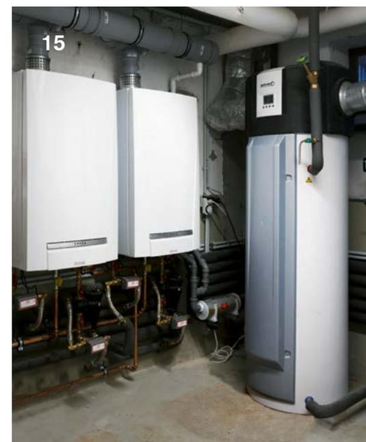
Stirlingmotoren angetrieben werden. Die BHKW erzeugen nach dem Prinzip der Kraft-Wärme-Kopplung Strom und Wärme im Verhältnis eins zu fünf. Im Sommer, wenn die Heizung nicht permanent laufen muss, wird die Warmwasseraufbereitung von einer Wärmepumpe übernommen, die über einen 300 Liter fassenden Warmwasserspeicher verfügt und ihren Strom entweder direkt aus der PV-Anlage oder aus den Stromspeichern bezieht.
