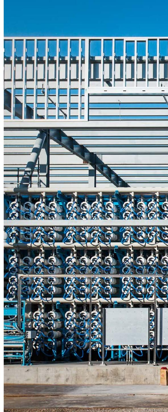
durch. Dafür ist enormer Druck notwendig, der wiederum einen hohen Energieaufwand verlangt. Aufgrund der Größe der Carlsbader Anlage stellte die Energieversorgung die Ingenieure vor eine erhebliche Herausforderung. Die Lösung: Der Einsatz neuartiger Rotationsdruckaustauscher, mittels derer Energie zurückgewonnen wird. Dabei wird die nach dem Verarbeitungsprozess verbliebene Druckenergie des Wassers
