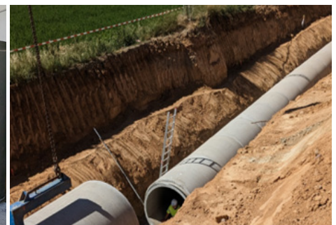
Elementos prefabricados para conducciones de saneamiento de secciones mixtas desplegados en la obra de Saneamiento y Depuración en Montijo-Puebla de la Calzada (Badajoz)
