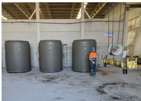
Elementos prefabricados para conducciones de saneamiento de secciones mixtas desplegados en la obra de Saneamiento y Depuración en Montijo-Puebla de la Calzada (Badajoz)
