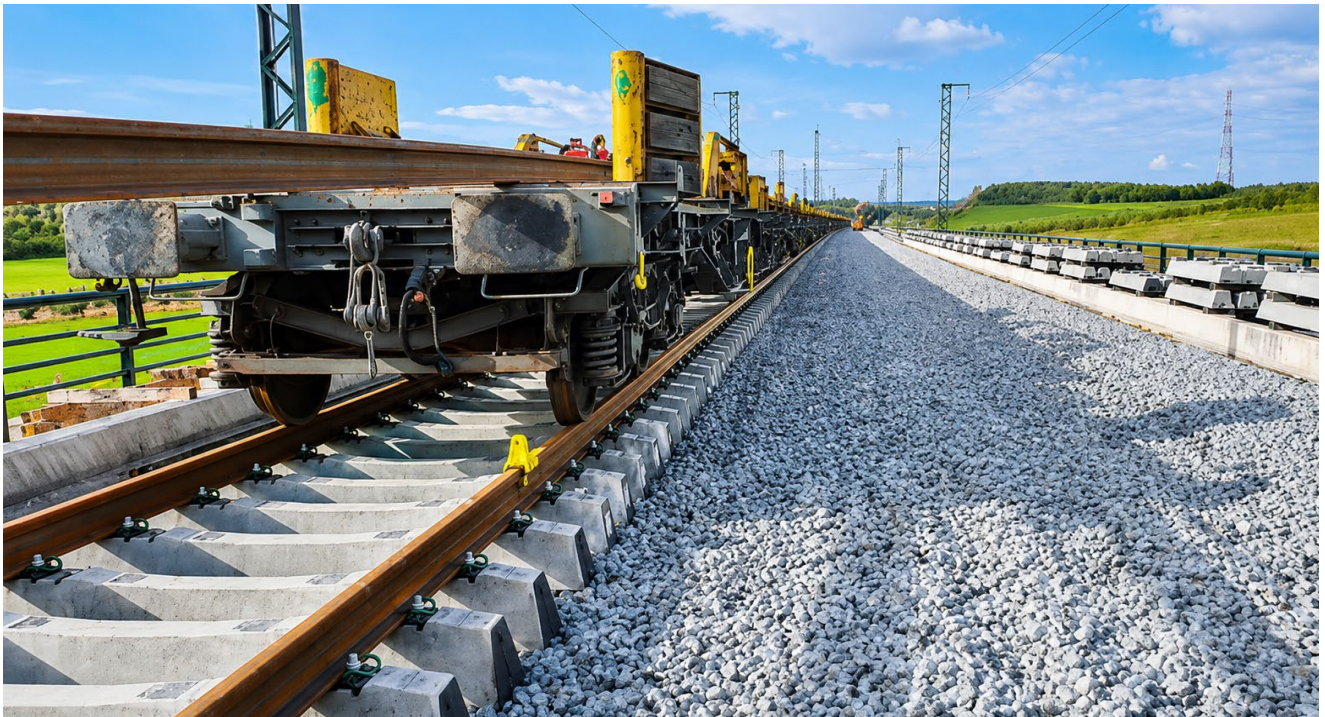
Extendido en plataforma ferroviaria.
