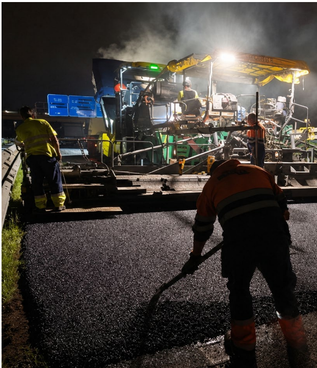
Extendido de PA-16 en tramo de prueba.
