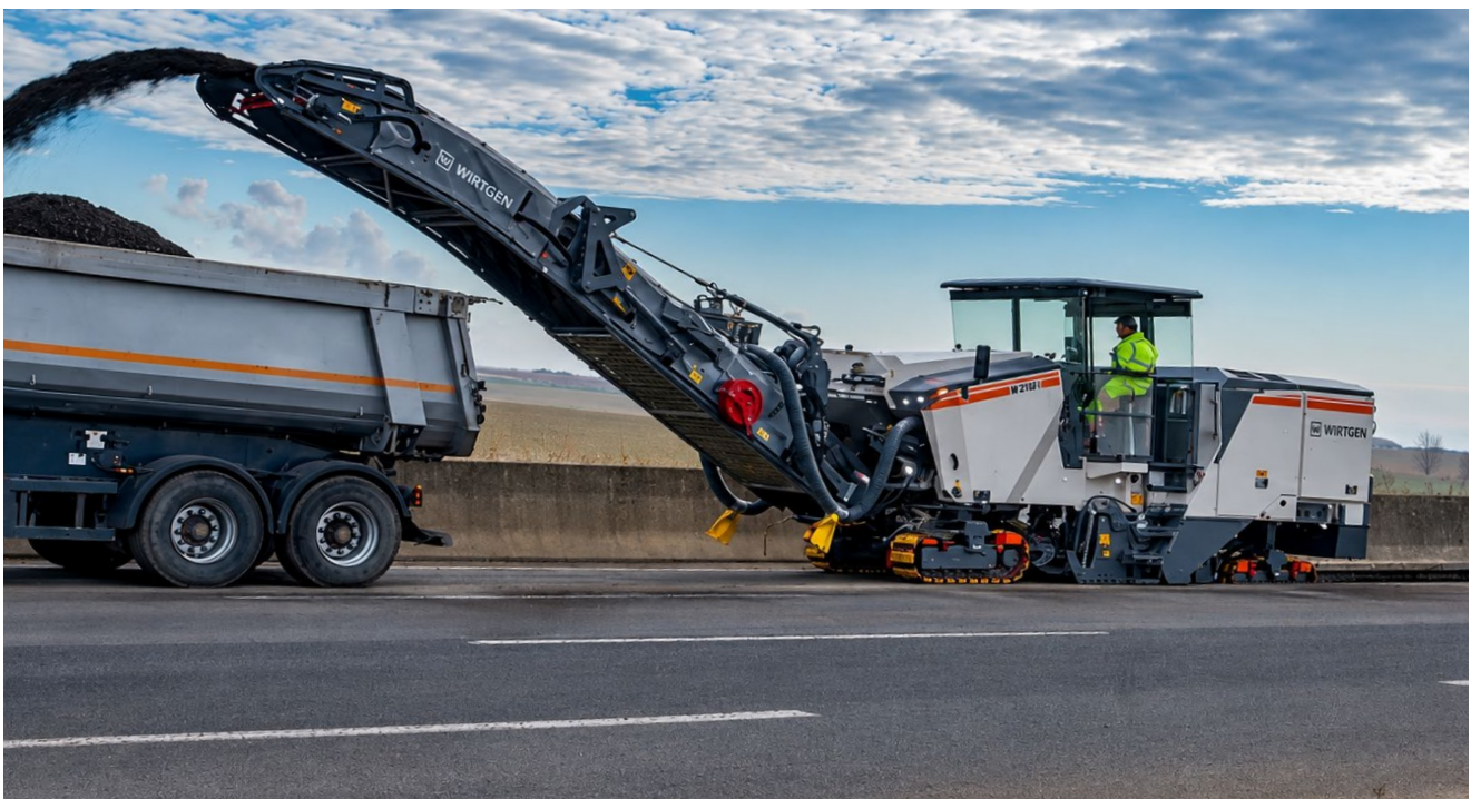
Obtención de residuos procedentes del fresado.
