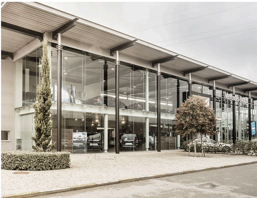
Anläggning i Aalst
