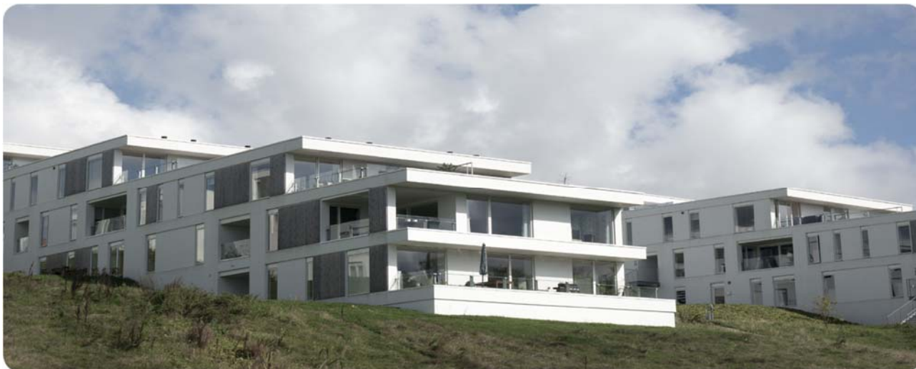
Etageejendomme bygget af H+H Termoblokke.
