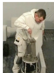
Multipladen® stilles på limspandens kant, lim trækkes på studsugen.
