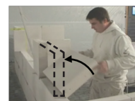
Multipladens kant lægges an mod væggen og vippes op på plads.
