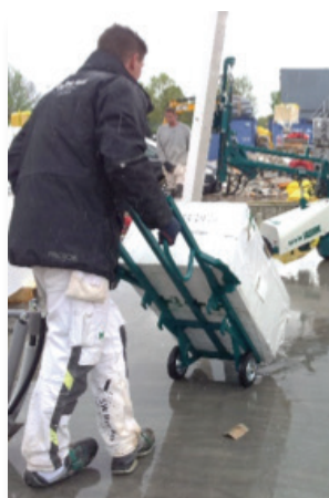
Blokgaflen H+H R'GO kan også anvendes selvstændigt til intern transport af f.eks. units.
