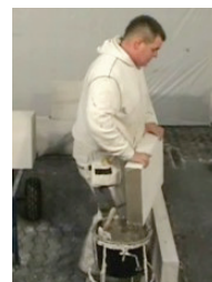
Multipladen® til 2. skifte løftes på plads.
