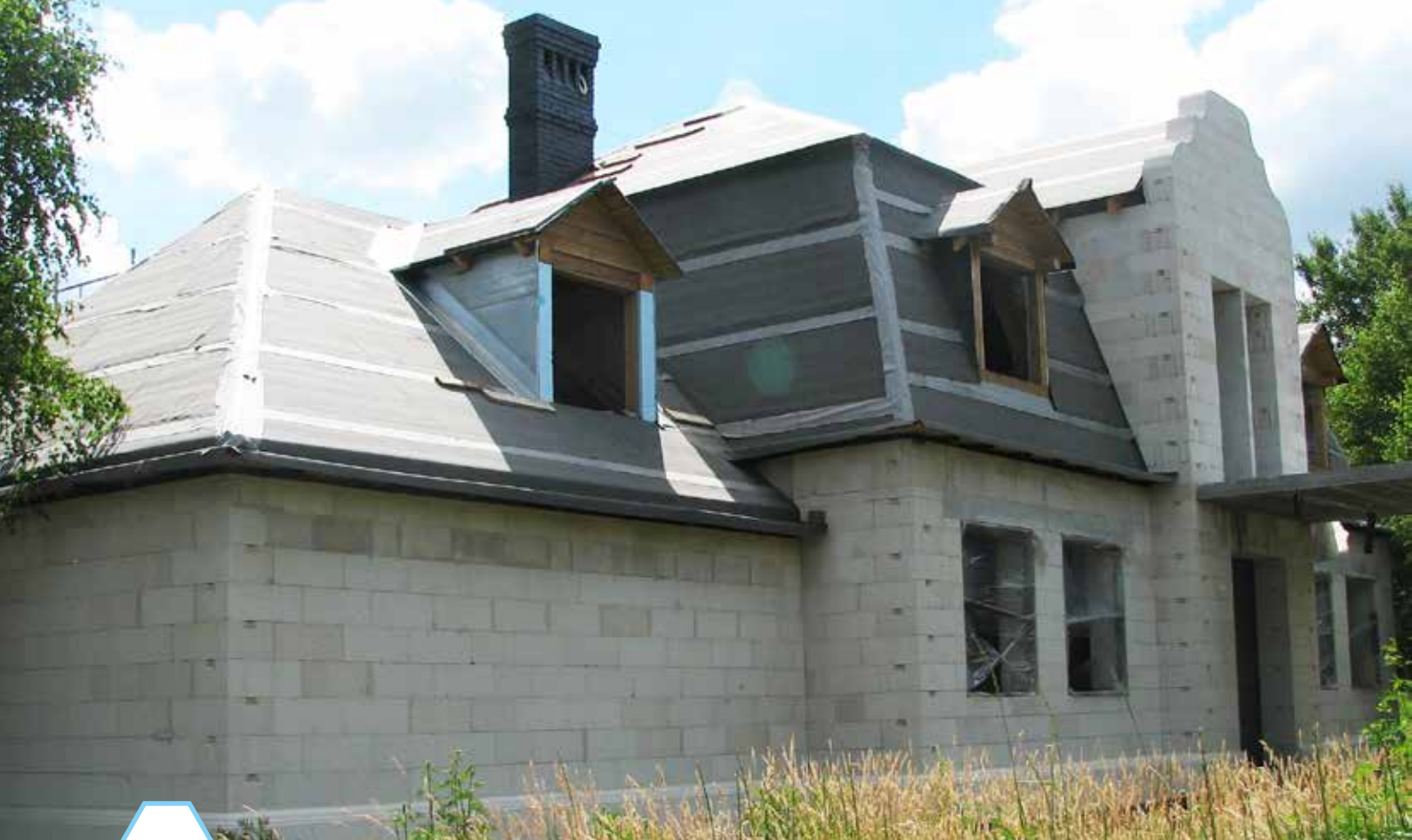
Ilustracja 40: Ściana jednowarstwowa
