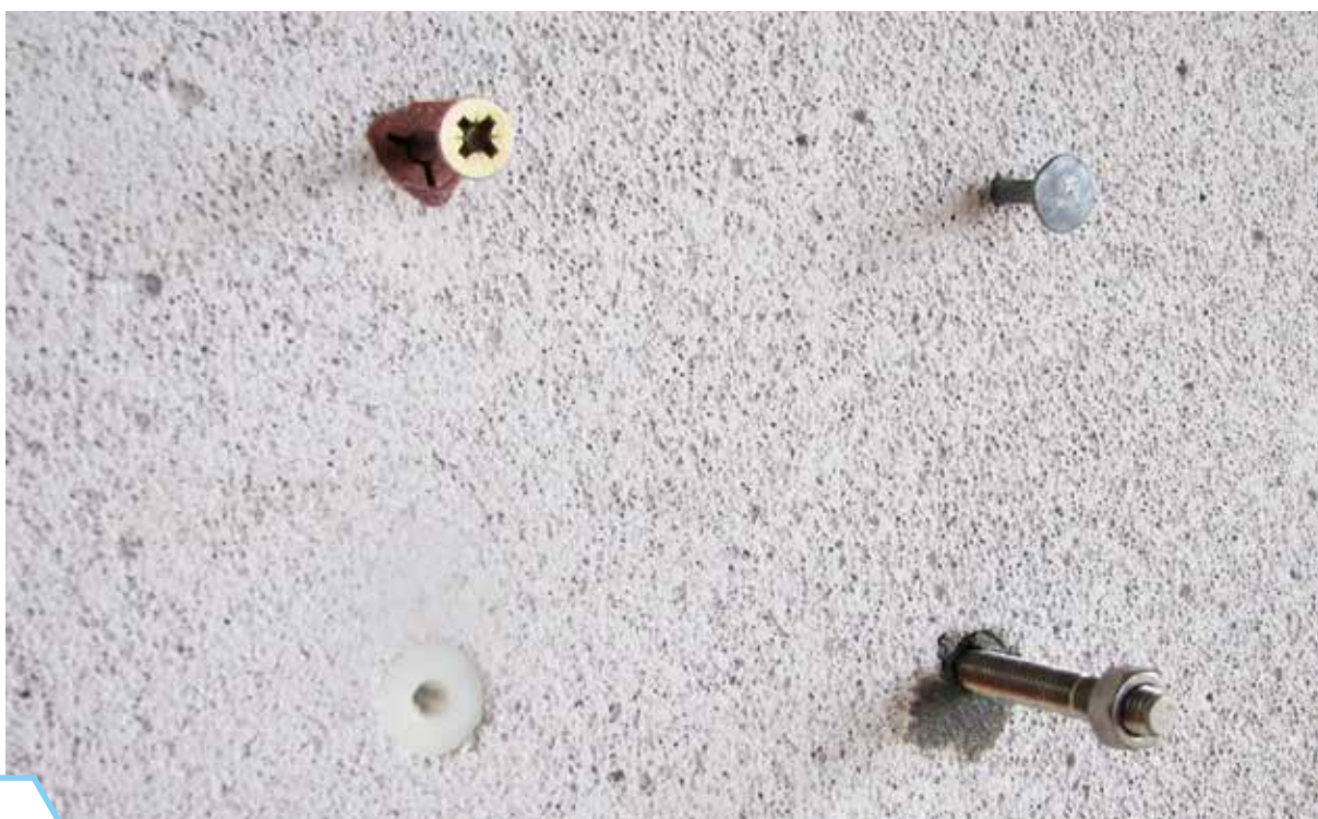
Ilustracja 43: Zamocowanie w betonie komórkowym
