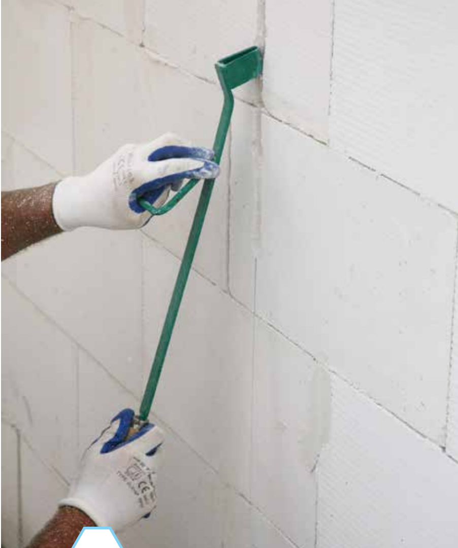
Ilustracja 31: Wykonywanie bruzd instalacyjnych
