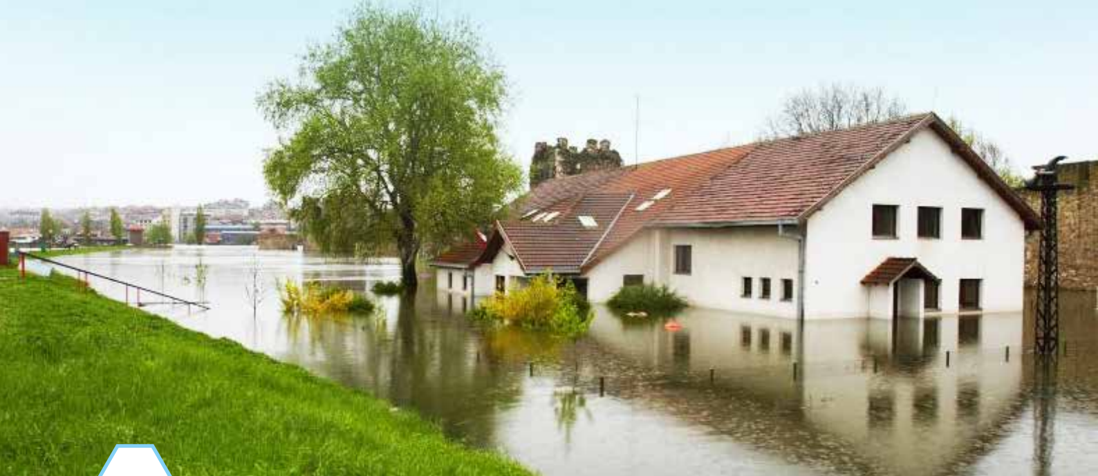
Ilustracja 25: Budynek z ABK w trakcie powodzi
