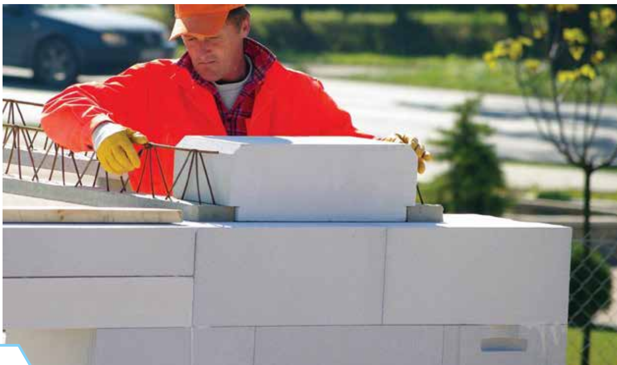
Ilustracja 24: Oparcie stropu na ścianie
