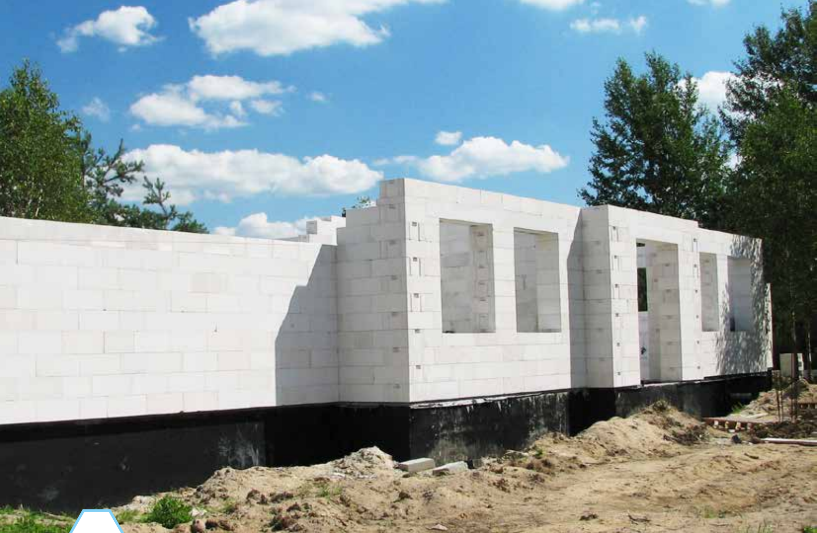
Ilustracja 42: Ściany z bloczków z betonu komórkowego
