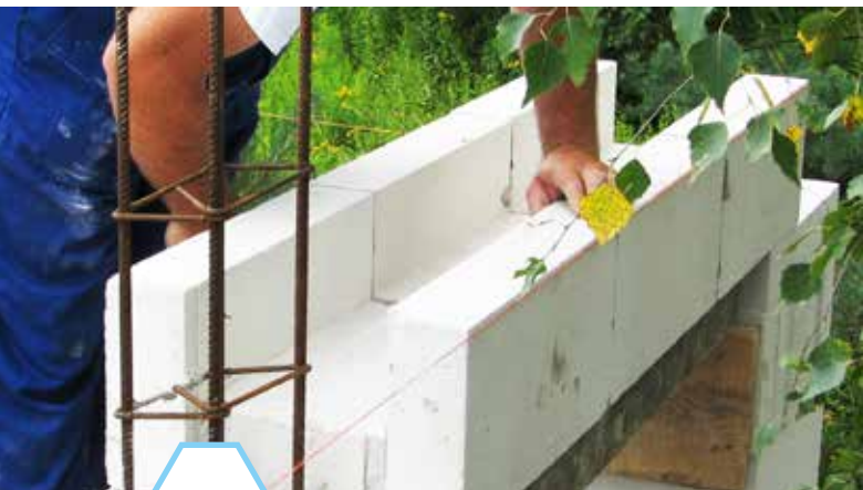
Ilustracja 13: Montaż elementów nadprożowych
