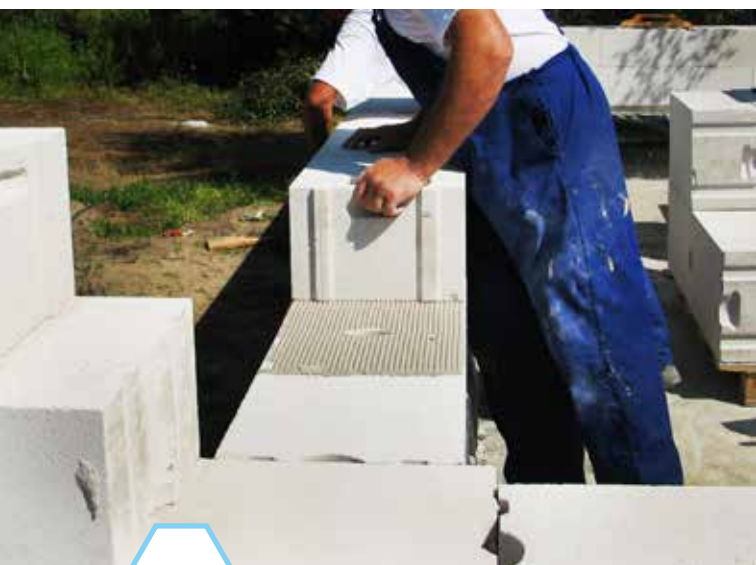
Ilustracja 30: Murowanie oraz pokazanie jednorodności ABK
