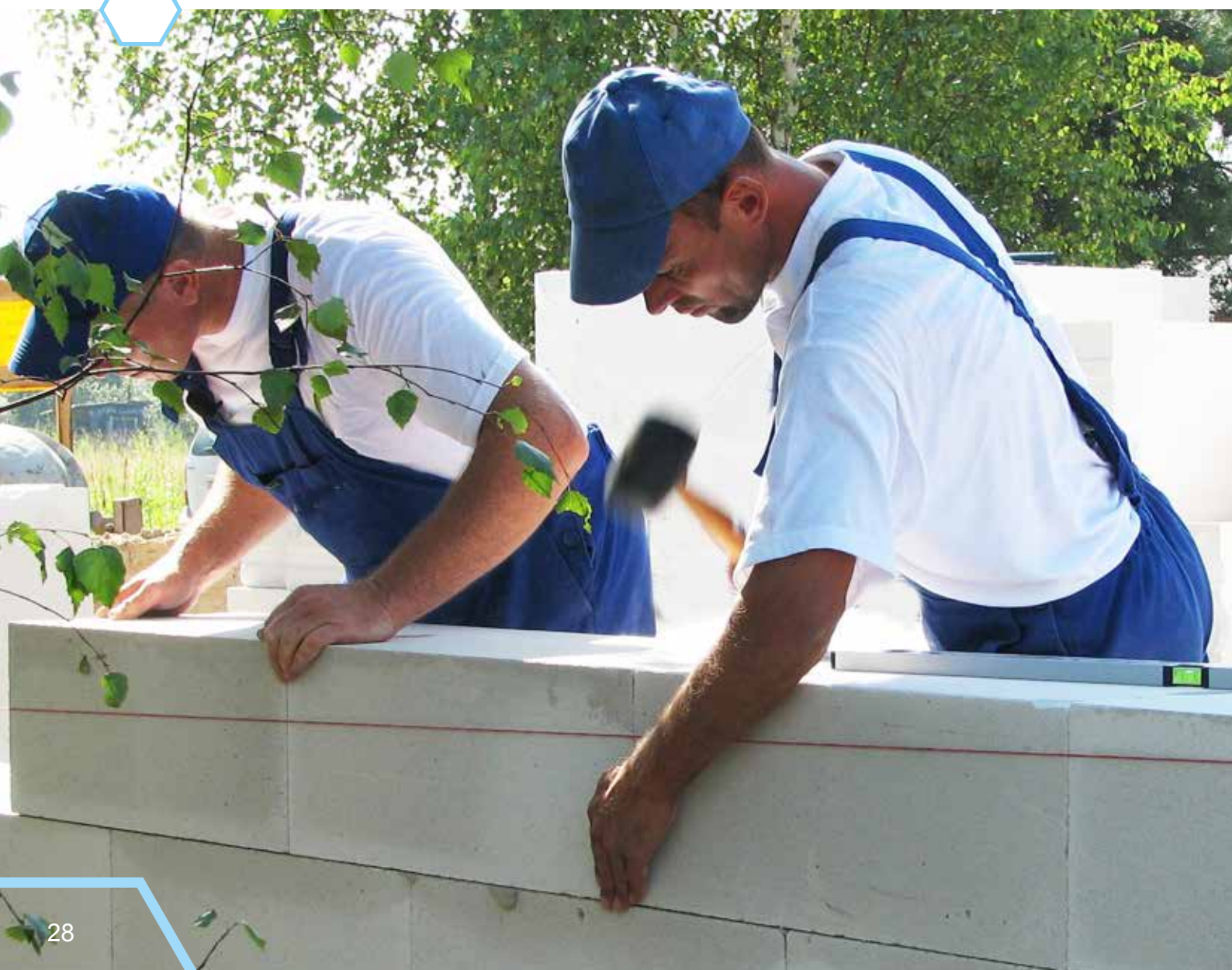
Ilustracja 28: Dobijanie bloczka gumowym młotkiem
