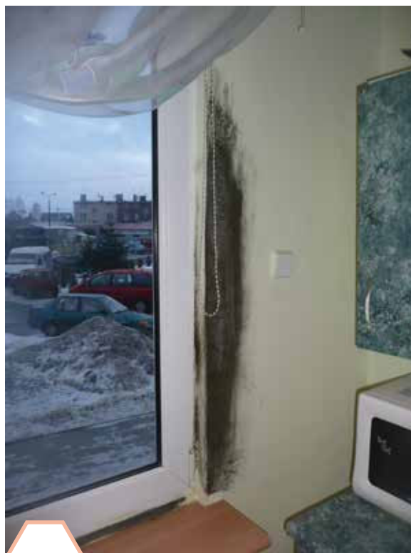
Rys. 2.1. Zagrzybienie fragmentu ściany zewnętrznej.
