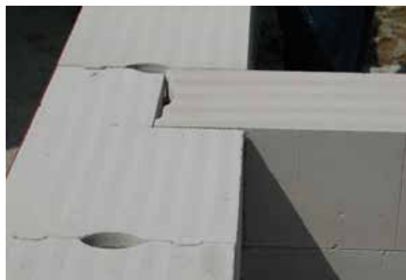
Rys. 6.9. Klasyczne sposoby skrzyżowania ścian z betonu komórkowego: a), b) wiązanie bloczków, c) wykonane skrzyżowanie
