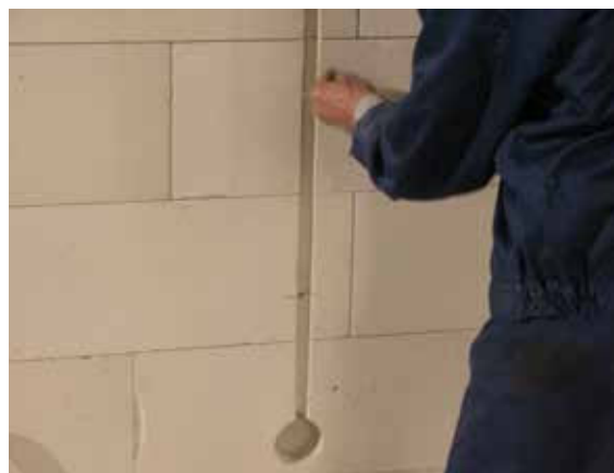
Rys. 6.17. Pionowa bruzda w murze z betonu komórkowego
