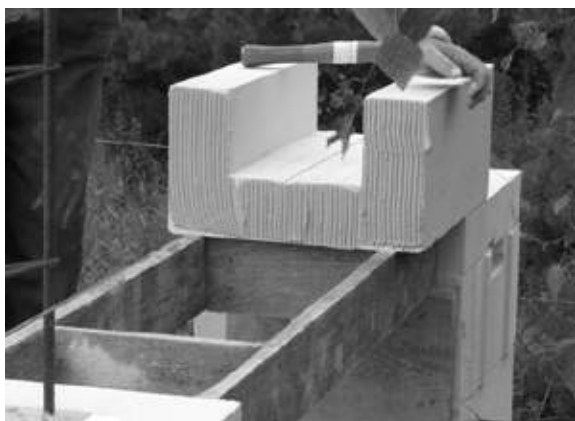
Ilustracja 9.49. Ponieważ kształtki U nie są profilowane, to trzeba je kleić za pomocą zaprawy cienkowarstwowej
