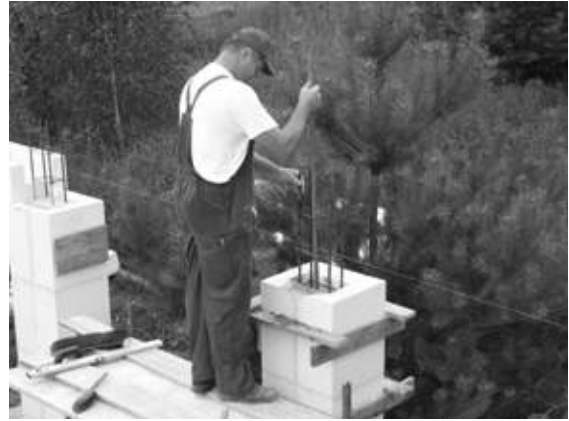
Ilustracja 9.70. Beton należy zagęścić
