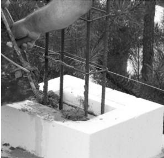
Ilustracja 9.68. Zalanie betonem szalunku i zbrojenia stupa
