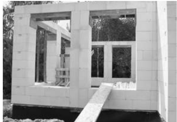
Ilustracja 9.71. Tak wygląda finalna konstrukcja filara wykonanego w kształtkach U. Jedynym materiałem w konstrukcji murowej.
