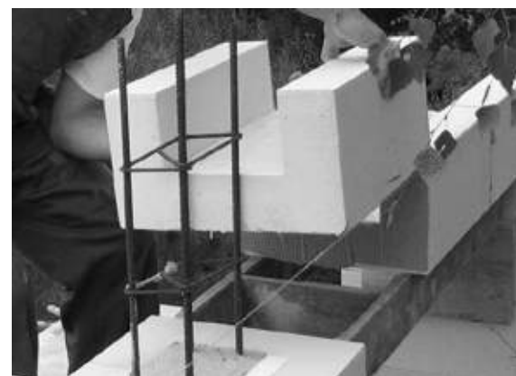
Ilustracja 9.53. Wmurowanie ostatniej kształtki
