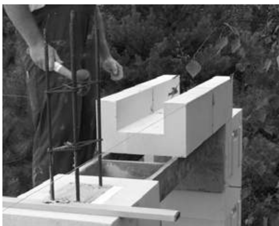
Ilustracja 9.50. Kolejna kształtka wmurowana
