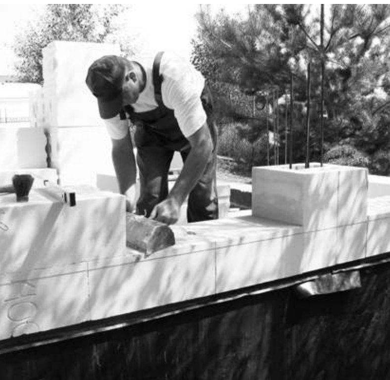
Ilustracja 6.2. Murowanie z wykorzystaniem narzędzi systemowych
