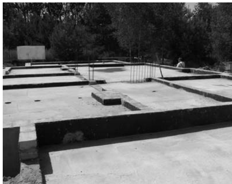
Ilustracja 9.10. Dokładność wykonania ścian fundamentowych wymaga wykonania pierwszej warstwy bloczków naziemia na zaprawie cementowej o grubości pozwalającej zniwelować różnice poziomów bloczków
