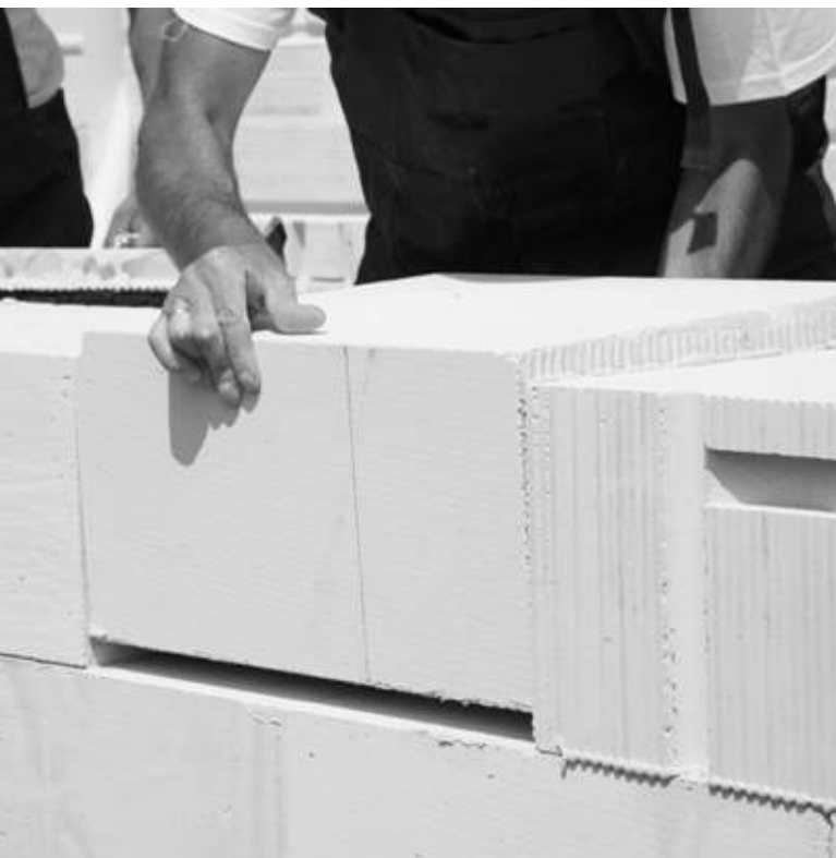
Ilustracja 9.8. Istotne jest ułożenie bloczka w miejscu wmurowania
