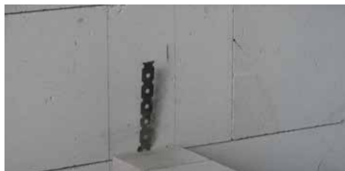
Ilustracja 9.34. Połączenie z konstrukcją (krawędź górna oraz boczne) należy wykonać w sposób zgodny z przyjętym w projekcie schematem statycznym, przy zastosowaniu odpowiednich łączników i prawidłowym ich rozmieszczeniu
