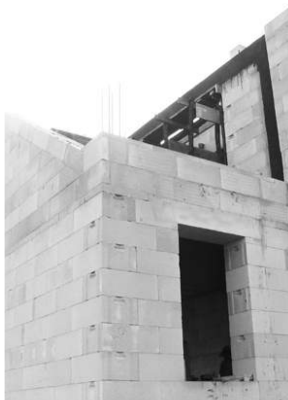
Ilustracja 1.2. Budowa z precyzyjnie wykonanymi murami z ABK
