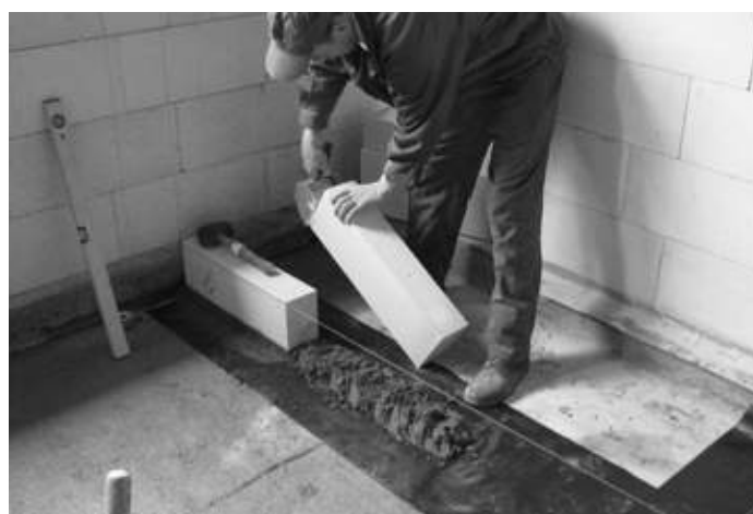
Ilustracja 9.33. Pierwszą warstwę należy wykonać na przekładce uniemożliwiającej zespolenie ściany ze stropem (papa, folia itp.). Dolna krawędź ściany wymaga zabezpieczenia przed przesunięciem w kierunku prostopadłym do osi ściany.
