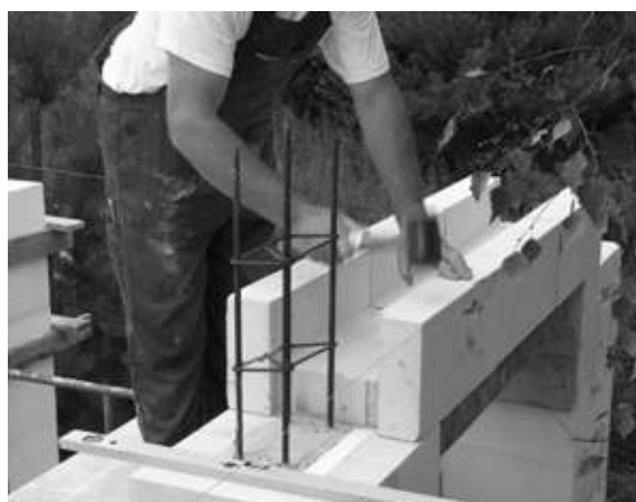
Ilustracja 9.54. Szalunek z kształtek U już wmurowany
