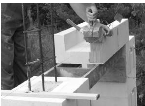
Ilustracja 9.51. Naniesienie zaprawy na powierzchnie boczne kształtki
