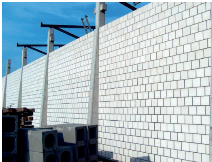
Fotografia 1. Nieotynkowane ściany wypełniające wykonane z H+H Silikatów w budynku halowym (fotografia wykonana podczas wznoszenia obiektu).
