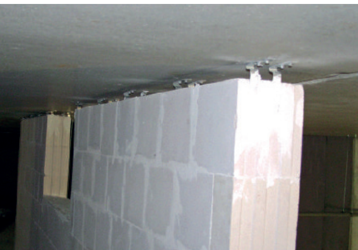
Fotografia 5 i 6. Połączenie ściany wypełniającej wzdłuż krawędzi górnej z konstrukcją.
