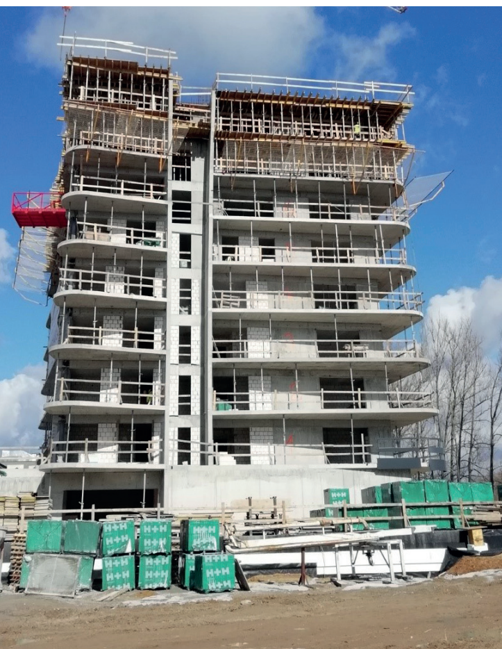
Fotografia 2. Ściany wypełniające w budynku mieszkalnym.
