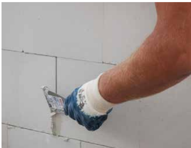
Fotografia 52. Wypełnianie szczelin pomiędzy bloczkami zaprawą.
