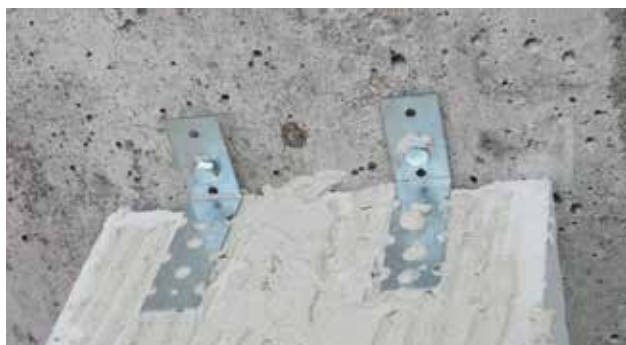
Fotografia 47. Łączniki K1 jako alternatywa do łącznika K2.
