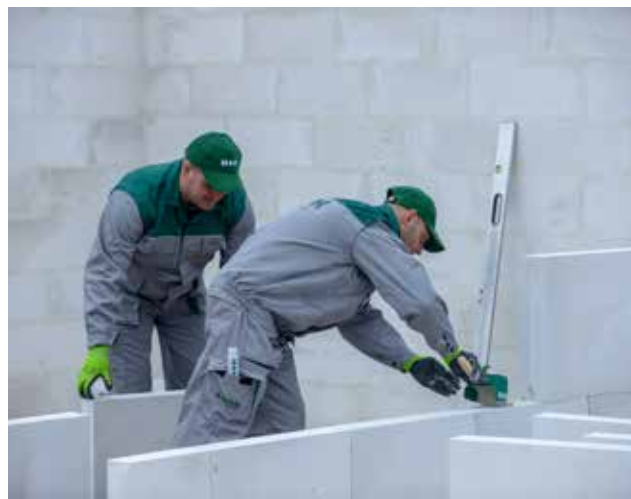
Fotografia 12. Nakładanie zaprawy cienkowarstwowej na ścianę działową za pomocą kielni.
