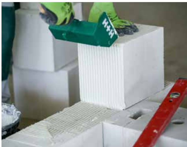
Fotografia 41. Murowanie bloczków ściany podłużnej w kolejnej warstwie.
