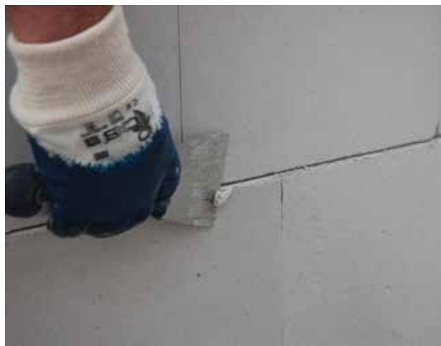
Fotografia 55. Usuwanie nadmiaru zaprawy murarskiej z powierzchni muru.
