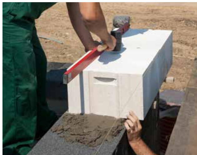
Fotografia 22. Osadzanie bloczka z betonu komórkowego w narożniku budynku.
