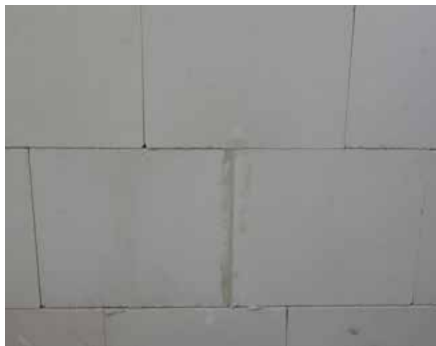
Fotografia 54. Szczelina uzupełniona zaprawą.
