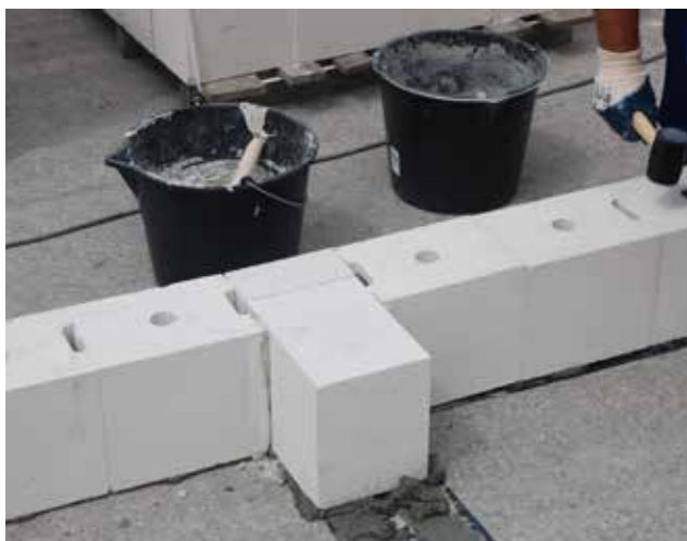
Fotografia 37. Połączenie ściany podłużnej wykonanej z bloczków H+H Silikat N15 ze ścianą prostopadłą wykonaną z bloczków H+H Silikat A18.
