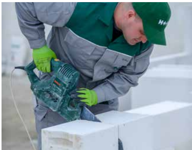
Fotografia 8. Docinanie błoczka z betonu komórkowego mechanicznie za pomocą piły typu „aligator”.
