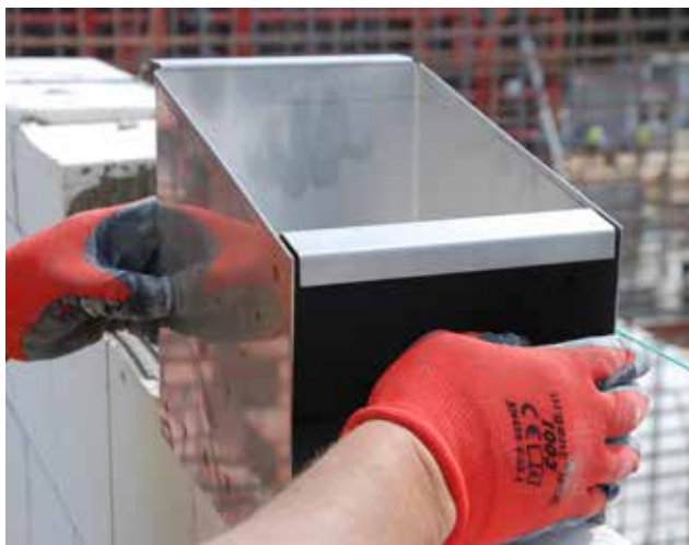
Fotografia 9. Skrzynka do nakładania zaprawy cienkowarstwowej (dostosowana do szerokości muru).
