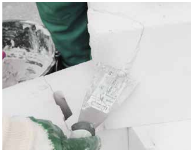
Fotografia 62. Usunięcie nadmiaru zaprawy
