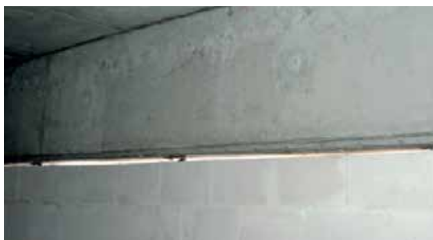
Fotografia 50. Łącznik DS umieszczony w spoinie pionowej wypełnionej zaprawą.
