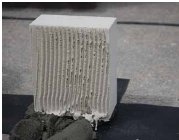
Fotografia 17. Pierwszy element silikatowy z nałożoną zaprawą do cienkich spoin na spoinę pionową.
