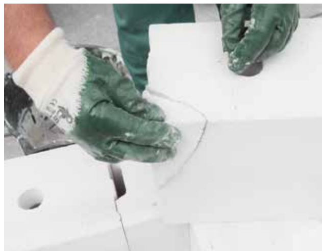
Fotografia 61. Wklejenie dopasowanego fragmentu błočka za pomocą zaprawy do cienkich spoin
