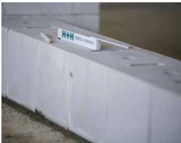
Fotografia 25. Pierwsza warstwa H+H Silikatów wymurowana na zaprawie zwykłej gotowa do nakładania zaprawy cienkowarstwowej.
