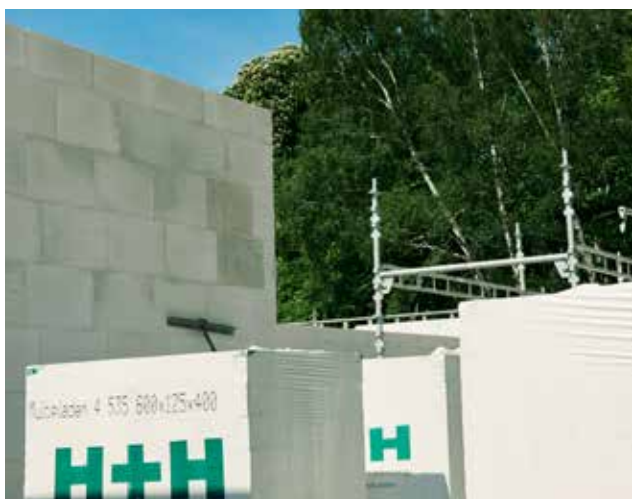
Fotografia 3. Palety z blockami z betonu komórkowego ustawione w pobliżu miejsca wbudowania.
