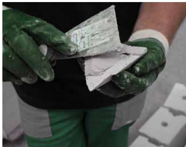
Fotografia 60. Przygotowanie małego elementu błočka do wklejenia w ubytek.
