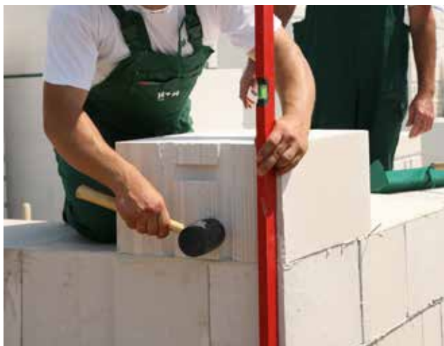
Fotografia 32. Do precyzyjnego ustawienia bloczka niezbędna jest poziomica.
