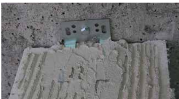
Fotografia 46. Łącznik K2 zatopiony w zaprawie do cienkich spoin.
