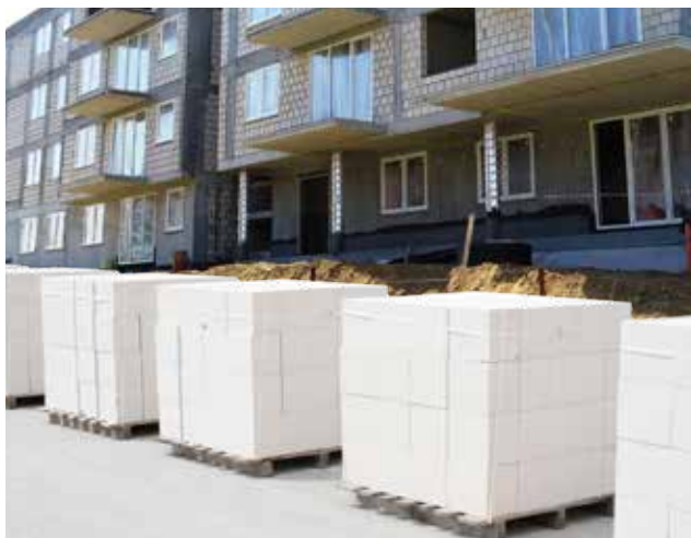
Fotografia 2. Ustawienie palet wzdłuż przyszłego muru ograniczającego transport na budowie.
