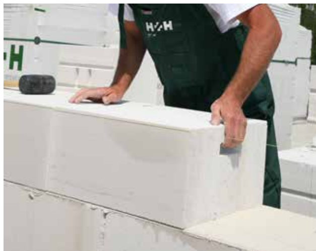
Fotografia 34. Dokładanie kolejnych bloczków warstwy metodą opuszczania z góry.
