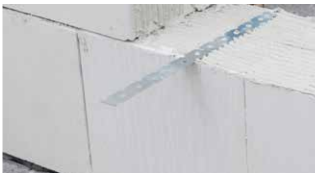
Fotografia 43. Łącznik P30 umieszczony w warstwie zaprawy.
