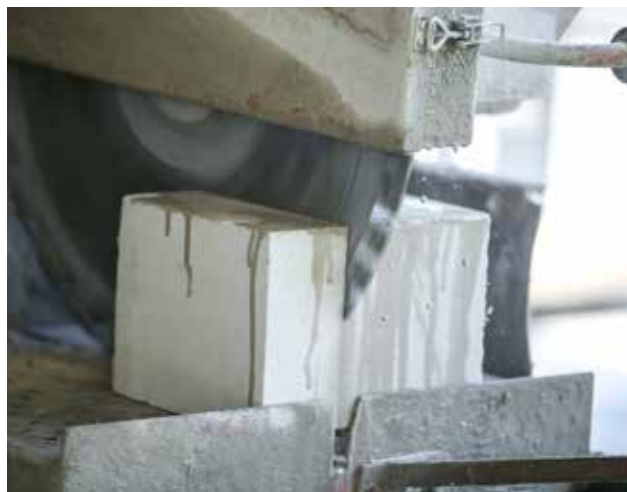
Fotografia 5. Bloczki H+H Silikaty przycinane za pomocą stołowej piły tarczowej.
