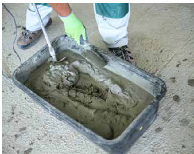
Fotografia 15. Przygotowywanie zwykłej zaprawy cementowej w kastrze prostokątnej.
