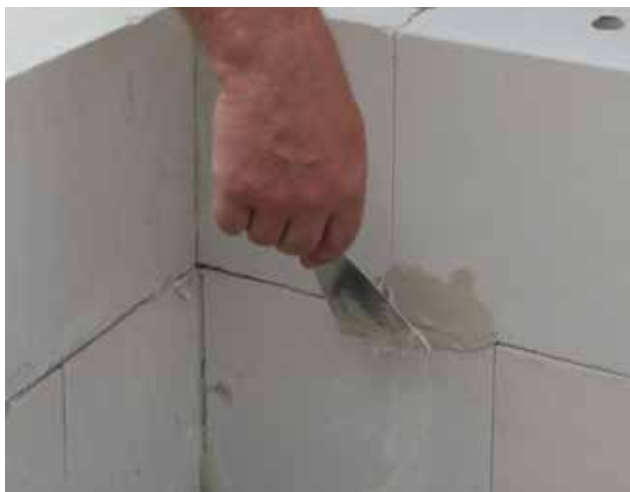
Fotografia 58. Mniejsze ubytki wypełnia się zaprawą do cienkich spoin.
