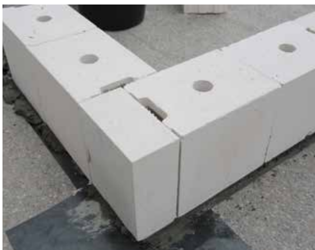
Fotografia 21. Pierwsza warstwa muru wykonanego z H+H Silikatów.
