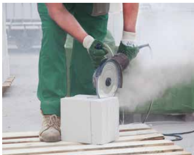
Fotografia 6. Docinanie silikatowego elementu murowego szlifierką kątową.
