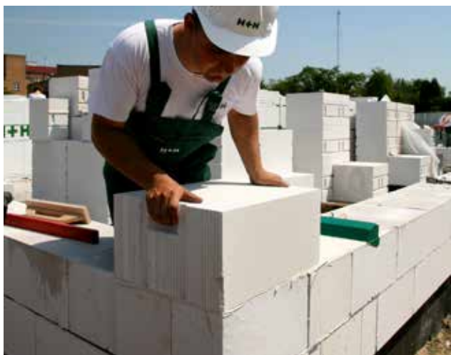
Fotografia 31. Ustawianie pierwszego bloczka z betonu komórkowego w narożniku kolejnej warstwy.
