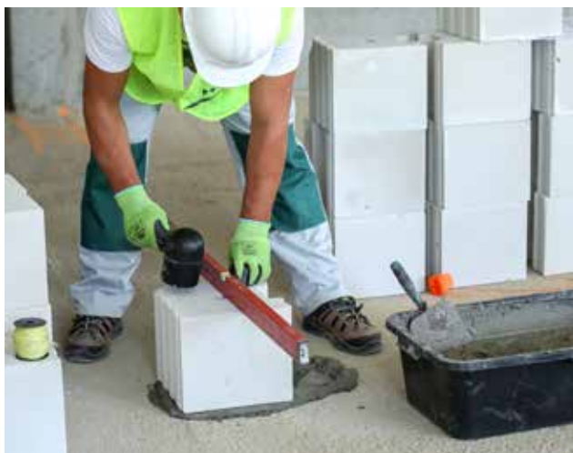
Fotografia 19. Użycie młotka gumowego ułatwia precyzyjne ustawienie elementu.
