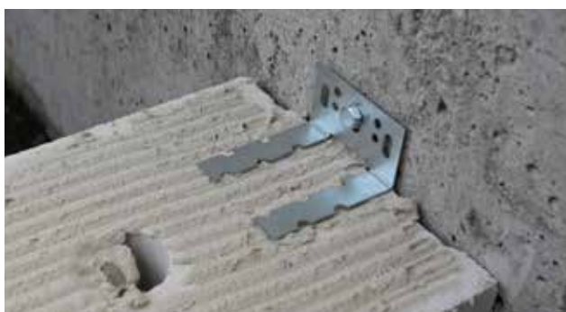
Fotografia 45. Łącznik K2 do połączeń murów np. z konstrukcją żel-betową.
