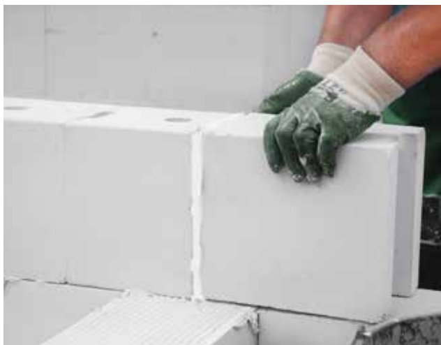
Fotografia 38. Wypełnienie zaprawą spoiny pionowej przypadającej w środku połączenia podczas montażu elementów drugiej warstwy.
