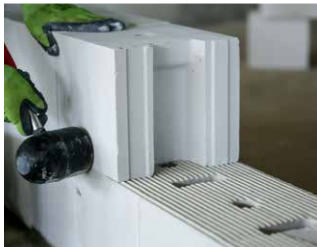
Fotografia 29. Każdy bloczek stabilizujemy poprzez uderzenia gumowym młotkiem.
