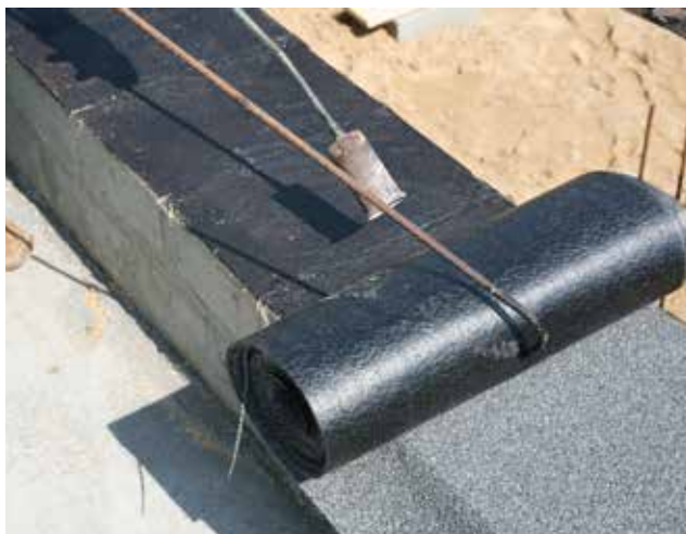
Fotografia 14. Układanie poziomej izolacji przeciwwilgociowej pod pierwszą warstwę muru.
