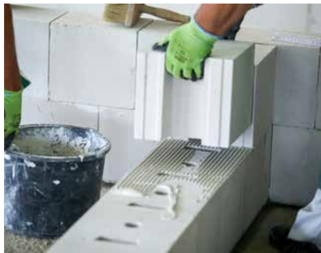
Fotografia 28. Prawidłowy kierunek ustawiania bloczka – pionowo z góry.
