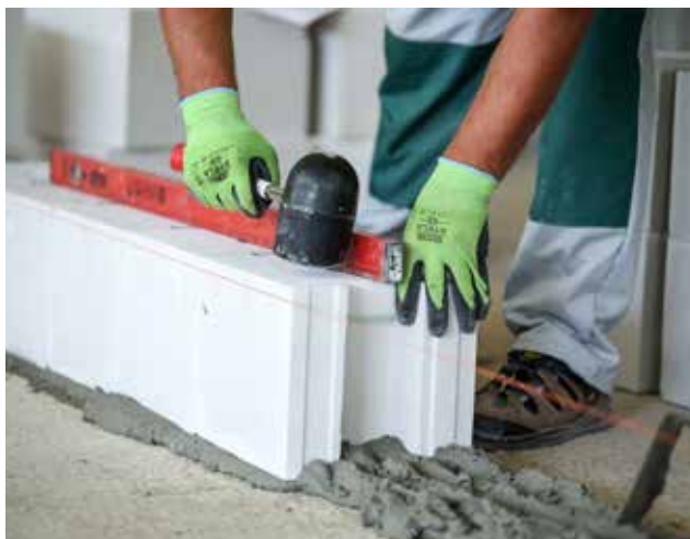
Fotografia 20. Układanie kolejnych bloczków pierwszej warstwy.
