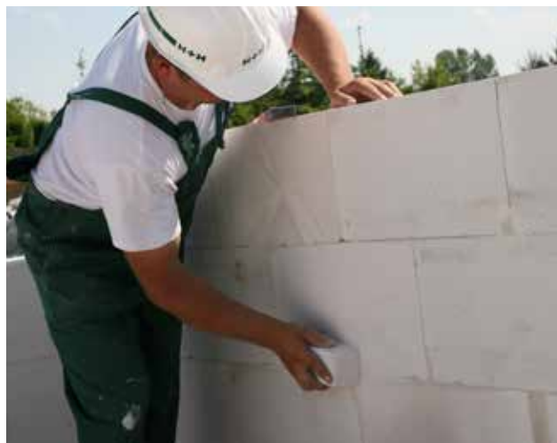
Fotografia 56. W przypadku murów z betonu komórkowego do wyrównania spoin można użyć kawałka bloczka z betonu komórkowego.
