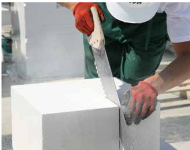
Fotografia 7. Błoczek z betonu komórkowego przecinany za pomocą ręcznej piły widoowej.
