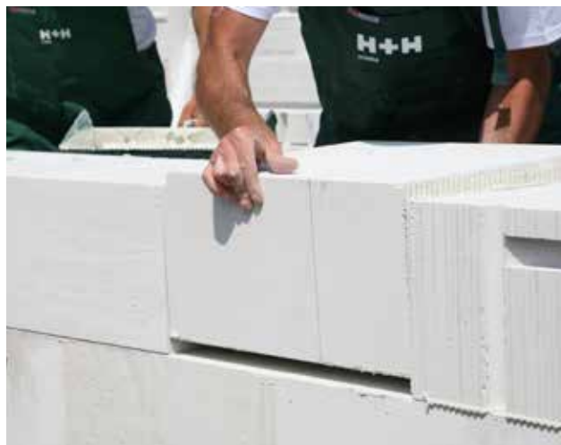
Fotografia 36. Osadzanie bloczka przyciętego do żądanych wymiarów.
