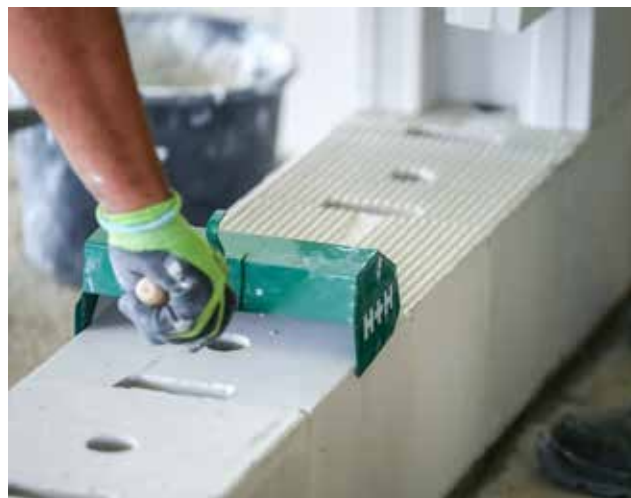
Fotografia 10. Kielnie do zaprawy cienkowarstwowej na przykładzie muru z H+H Silikatów.
