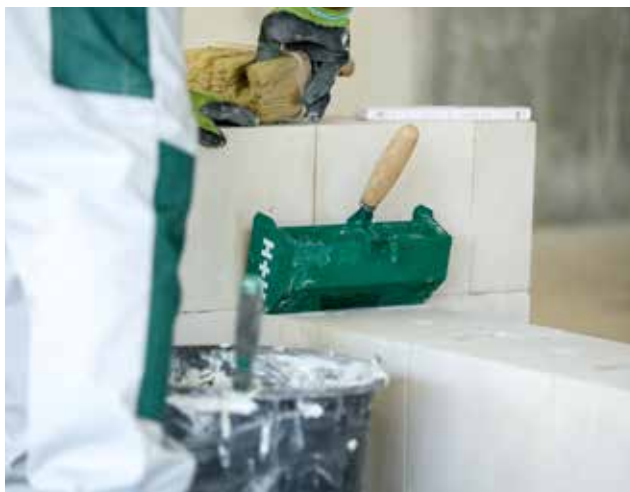
Fotografia 26. W miejscach, gdzie powierzchnia boczna jednego z elementów styka się z powierzchnią czołową elementu dostawianego w drugim kierunku, spoinę pionową należy również wypełnić zaprawą.
