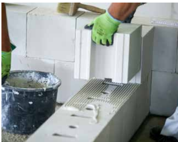
Fotografia 42. Osadzanie bloczka ściany prostopadłej.
