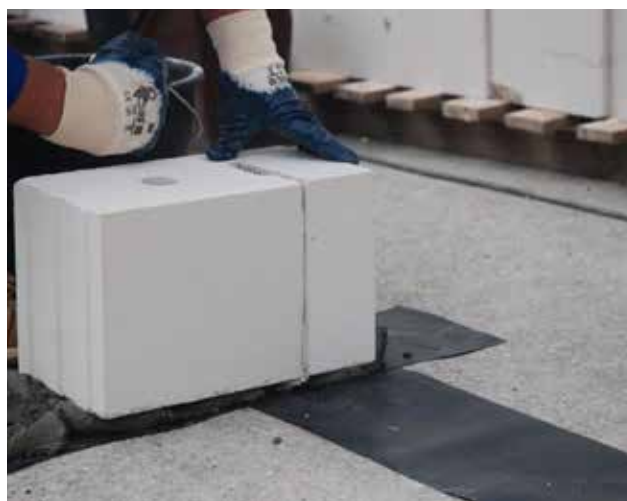
Fotografia 18. Ustawianie w narożniku drugiego silikatowego elementu murego (blok podstawowy).
