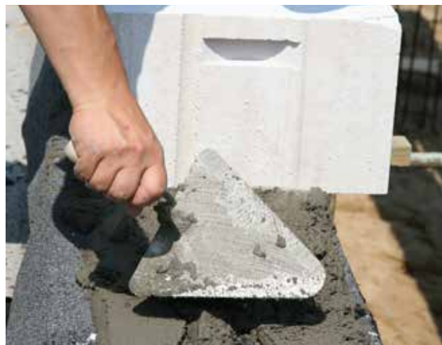
Fotografia 23. Pierwsza warstwa muru jednowarstwowego z betonu komórkowego (bez dodatkowej warstwy ocieplenia).
