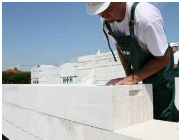
Fotografia 35. Widok kolejnych warstw muru z bloczków z betonu komórkowego.
