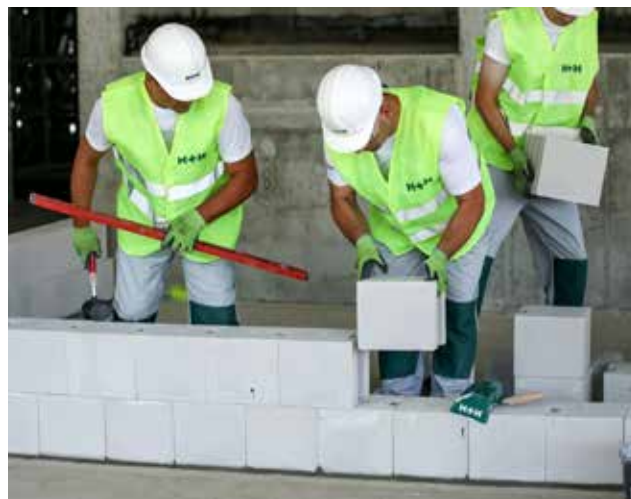
Fotografia 30. Podczas prac murarskich należy bezwzględnie pamiętać o prawidłowym przewiązaniu konstrukcji murowej (mijanie się spoin pionowych w kolejnych warstwach).
