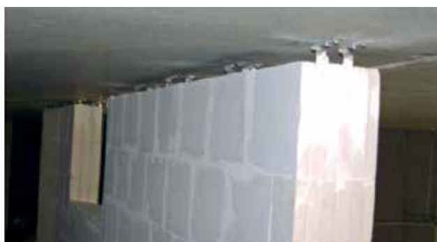
Fotografia 49. Łącznik DS do połączeń ścian wypełniających ze stropem.
