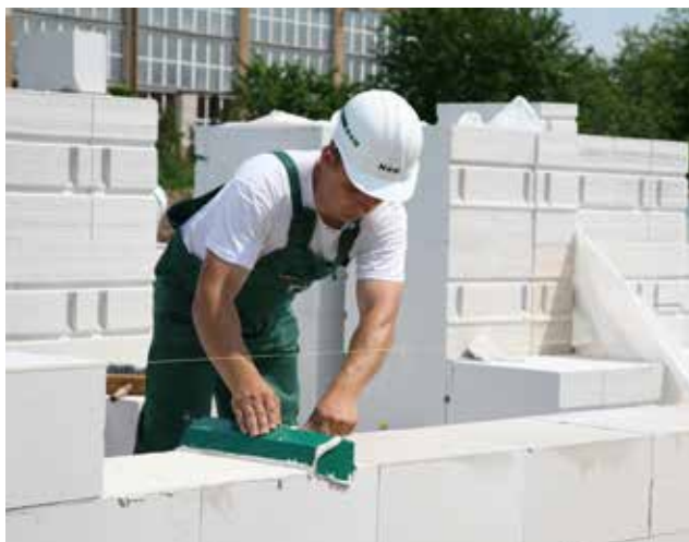
Fotografia 33. Nakładanie zaprawy cienkowarstwowej za pomocą kielni z ząbkami.
