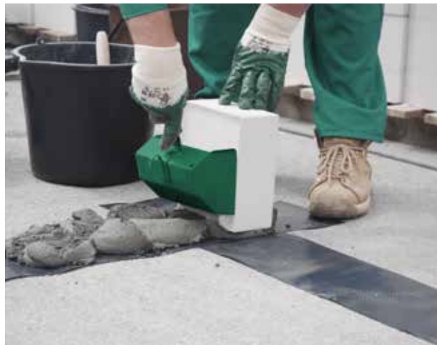
Fotografia 16. Ustawienie pierwszego silikatowego elementu murego (blok półkowy) w najwyższym położonym narożniku budynku.
