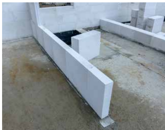
Fotografia 24. Pierwsze warstwy ścian wewnętrznych (nośnych i nienośnych).
