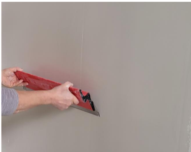
Fot. 11. Wyrównywanie nałożonej gładzi cienkowarstwowej nożem.
