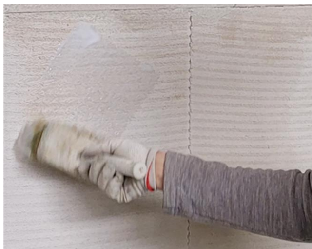
Fot. 8. Gruntowanie ściany preparatem dobranym do stosowanej gładzi docelowej.
