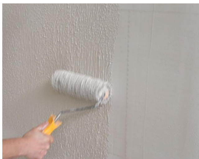
Fot. 9. Nakładanie gładzi cienkowarstwowej za pomocą wałka.
