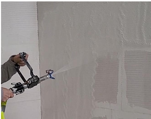
Fot. 10. Nakładanie gładzi cienkowarstwowej agregatem tynkarskim.
