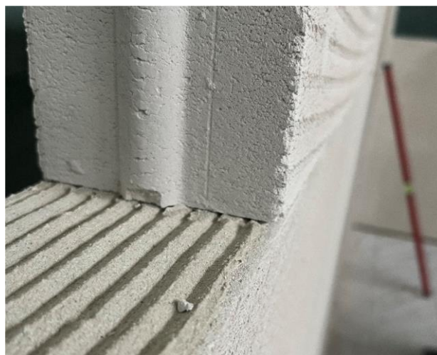
Fot. 4. Kolejne warstwy z Paneli TEMPO PRO układane na zaprawie H+H do cienkich spoin.
