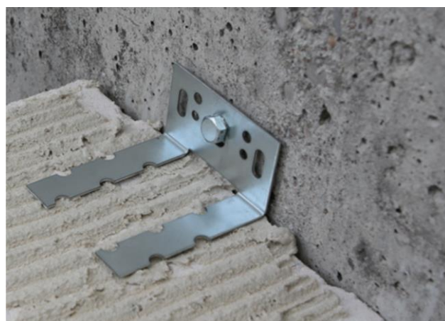
Fot. 6. Połączenie ściany w Systemie TEMPO PRO z konstrukcją boczną (np. łącznik K2).
