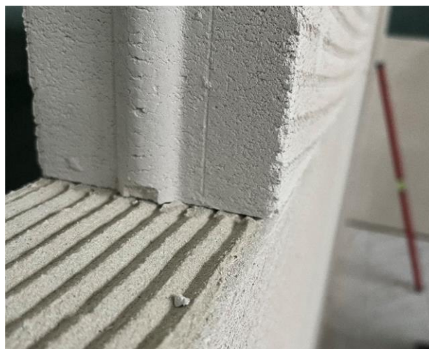
Fot. 4. Kolejne warstwy z Paneli TEMPO PRO układane na zaprawie H+H do cienkich spoin.
