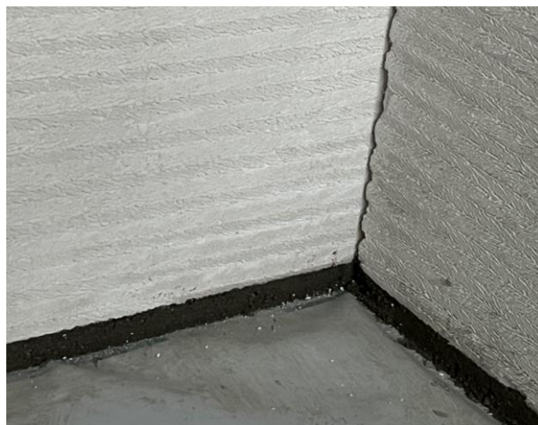
Fot. 3. Pierwsza warstwa Paneli TEMPO PRO układana na zaprawie cementowej.
