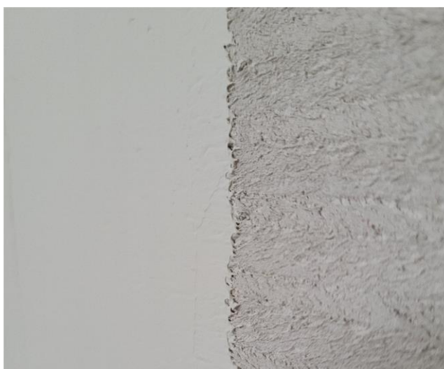
Fot. 12. Ścianki wykonane w Systemie TEMPO PRO wykończone cienkowarstwową gładzią.
