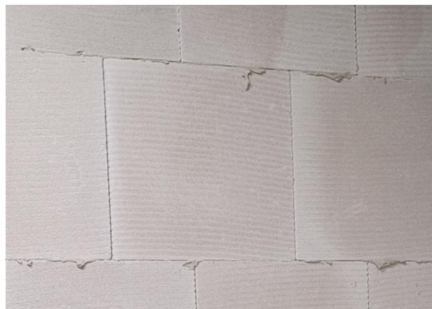
Fot. 5. Panele w kolejnych warstwach powinny zachodzić na siebie nie mniej niż 100 mm.
