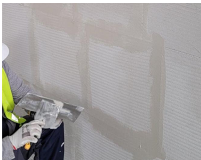
Fot. 7. Szpachlowanie wszystkich spoin pionowych i poziomych.
