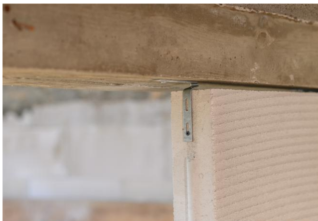
Fot. 3. Łącznik DS w połączeniu ściany działowej z konstrukcją w górnej krawędzi.
