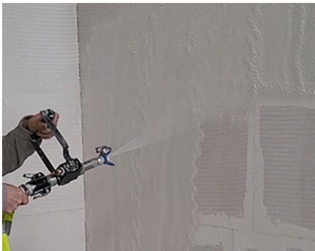
Fot. 13. Nakładanie gładzi cienkowarstwowej agregatem tynkarskim.
