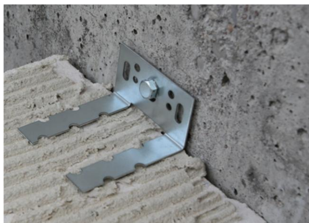
Fot. 7. Połączenie ściany w Systemie TEMPO PRO z konstrukcją boczną (np. łącznik K2).
