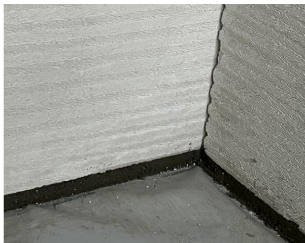
Fot. 3. Pierwsza warstwa Paneli TEMPO PRO układana na zaprawie cementowej.
