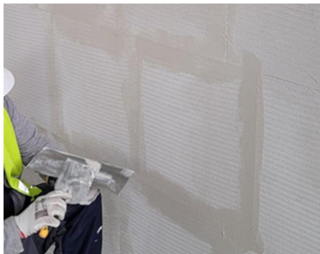
Fot. 10. Szpachlowanie wszystkich spoin pionowych
