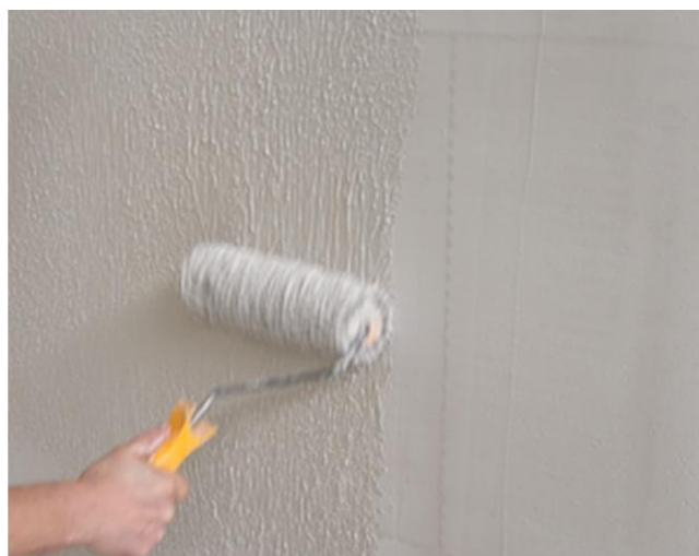
Fot. 12. Nakładanie gładzi cienkowarstwowej za pomocą wałka.
