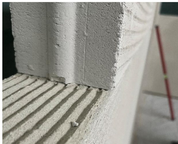
Fot. 5. Kolejne warstwy z Paneli TEMPO PRO układane na zaprawie H+H do cienkich spoin.
