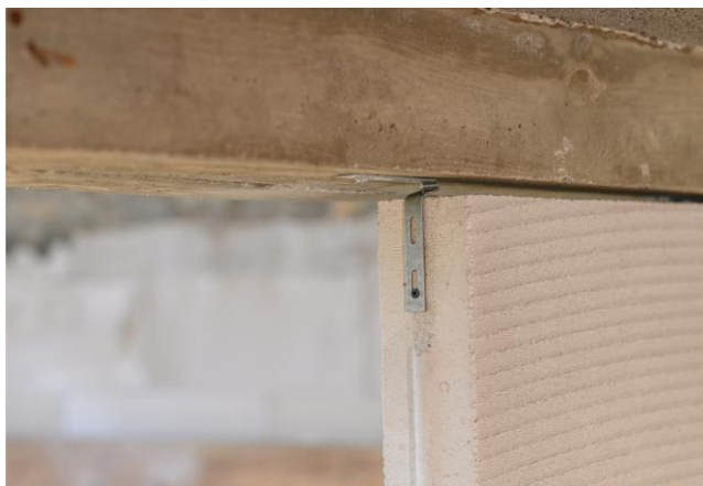
Fot. 8. Łącznik DS w połączeniu ściany działowej z konstrukcją w górnej krawędzi.
