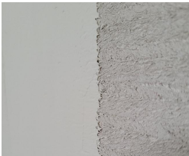
Fot. 15. Ściany wykonane w Systemie TEMPO PRO wykończone cienkowarstwową gładzią.
