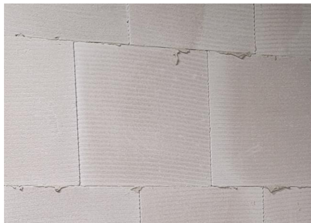
Fot. 6. Panele w kolejnych warstwach powinny zachodzić na siebie nie mniej niż 100 mm.
