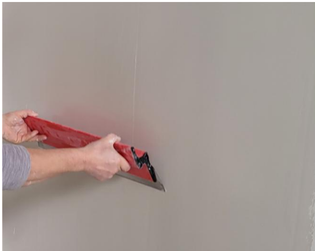
Fot. 14. Wyrównywanie nałożonej gładzi cienkowarstwowej nożem.
