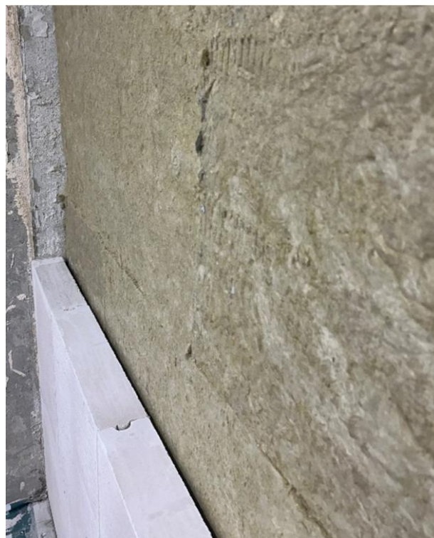
Fot. 9. Druga ściana odsunięta od przyklejonych arkuszy z wełny mineralnej o 1 cm.
