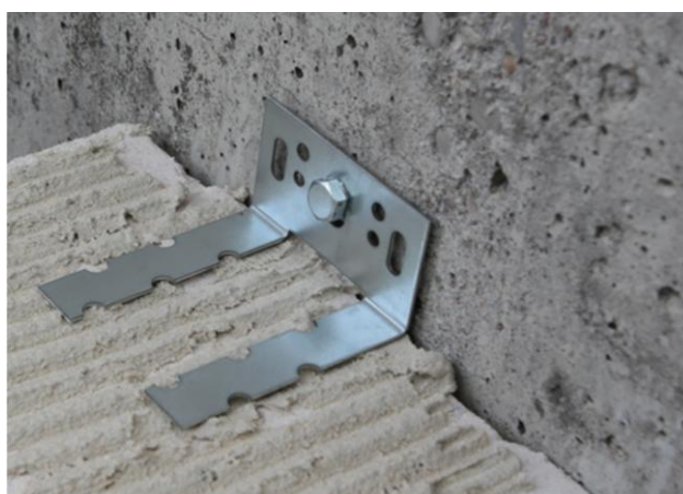
Fot. 8. Połączenie ściany w Systemie TEMPO PRO z konstrukcją boczną (np. łącznik K2).
