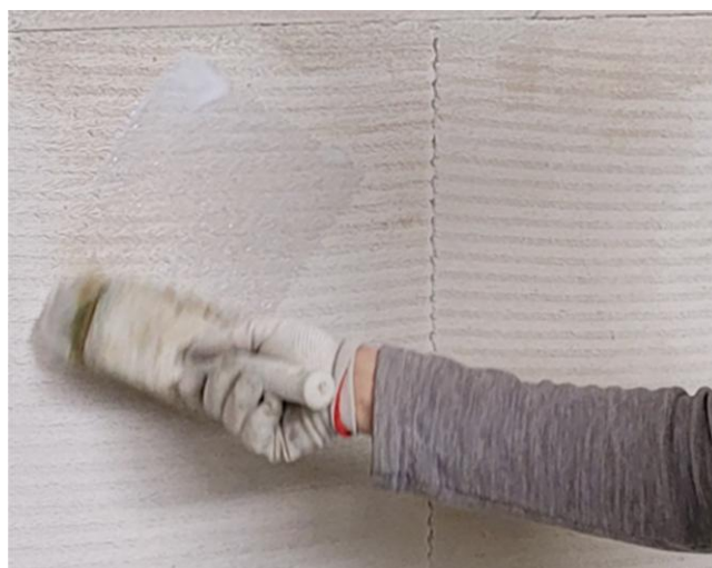
Fot. 12. Gruntowanie ściany preparatem dobranym do stosowanej gładzi docelowej.
