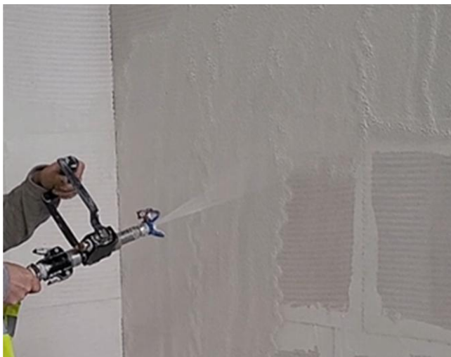
Fot. 14. Nakładanie gładzi cienkowarstwowej agregatem tynkarskim.
