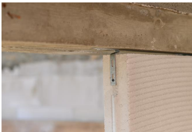
Fot. 9. Łącznik DS w połączeniu ściany działowej z konstrukcją w górnej krawędzi.
