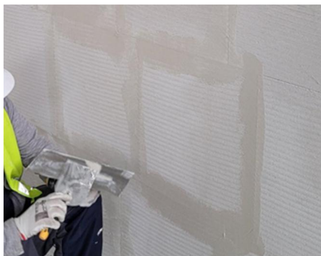
Fot. 11. Szpachlowanie wszystkich spoin pionowych.
