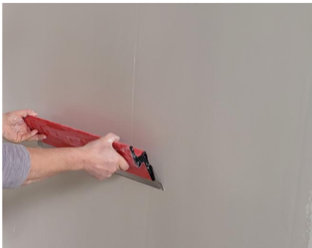
Fot. 15. Wyrównywanie nałożonej gładzi cienkowarstwowej nożem.
