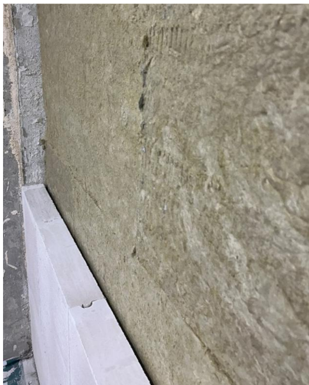
Fot. 10. Druga ściana odsunięta od przyklejonych arkuszy z wełny mineralnej o 1 cm.
