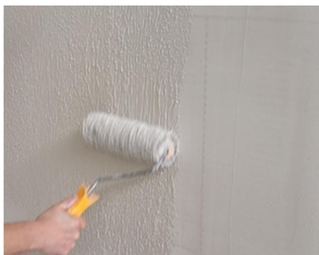
Fot. 13. Nakładanie gładzi cienkowarstwowej za pomocą wałka.
