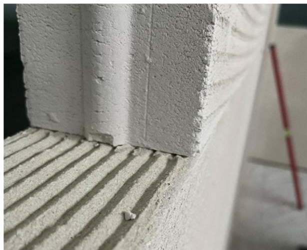
Fot. 6. Kolejne warstwy z Paneli TEMPO PRO układane na zaprawie H+H do cienkich spoin.
