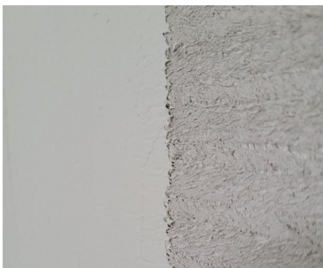
Fot. 16. Ściany wykonane w Systemie TEMPO PRO wykończone cienkowarstwową gładzią.
