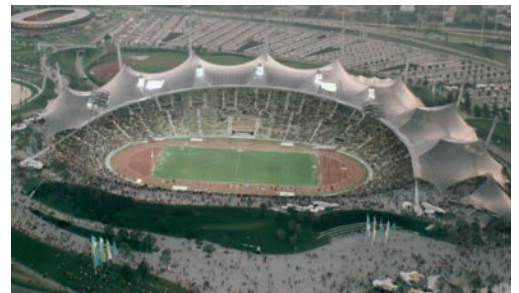
1972 Le stade de Munich et son toit partiel.
