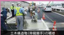
土木構造物(伸縮継手)の補修
