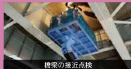
橋梁の接近点検
