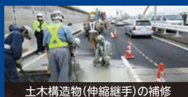
土木構造物(伸縮継手)の補修
