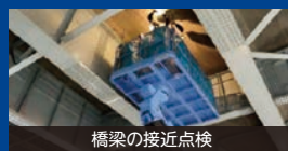
橋梁の接近点検
