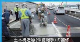
土木構造物(伸縮継手)の補修
