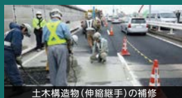
土木構造物(伸縮継手)の補修
