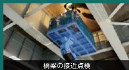
橋梁の接近点検
