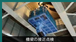
橋梁の接近点検
