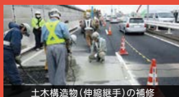
土木構造物（伸縮継手）の補修
