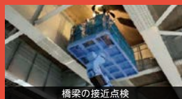
橋梁の接近点検
