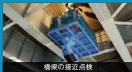
橋梁の接近点検
