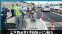
土木構造物(伸縮継手)の補修
