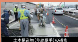
土木構造物(伸縮継手)の補修
