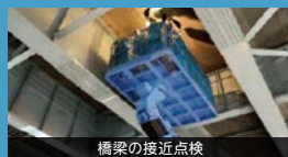
橋梁の接近点検
