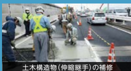
土木構造物(伸縮継手)の補修
