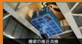
橋梁の接近点検
