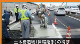
土木構造物（伸縮継手）の補修
