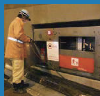
泡消火栓点検
