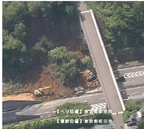
令和5年6月 東京都町田市 国道16号
