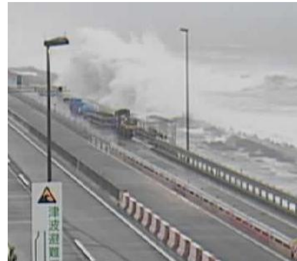
令和元年9月 神奈川県大磯町 国道1号
