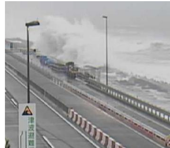
令和元年9月 神奈川県大磯町 国道1号
