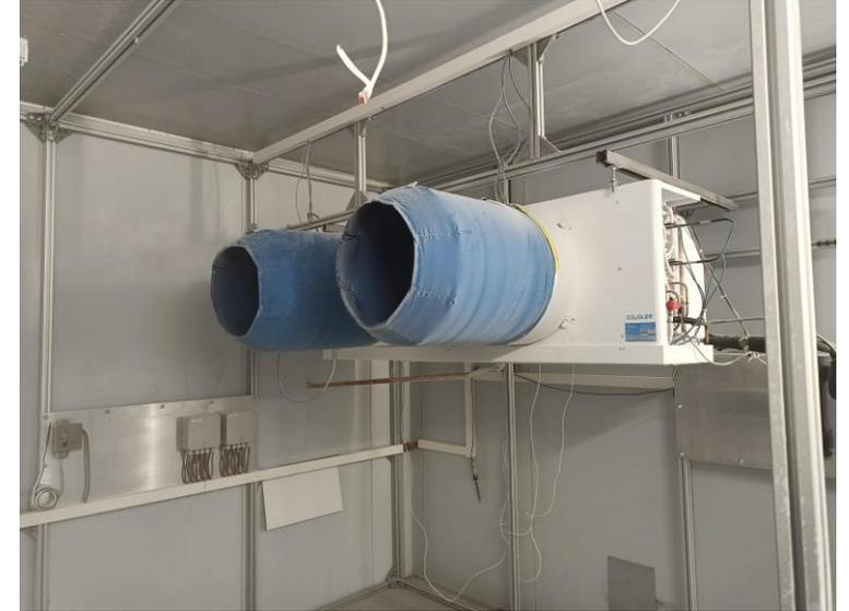
**Defrost Dome** und **Defrost Damper** hält die Abtauwärme im Luftkühler und erhöht dadurch die Abtauereffizienz.
