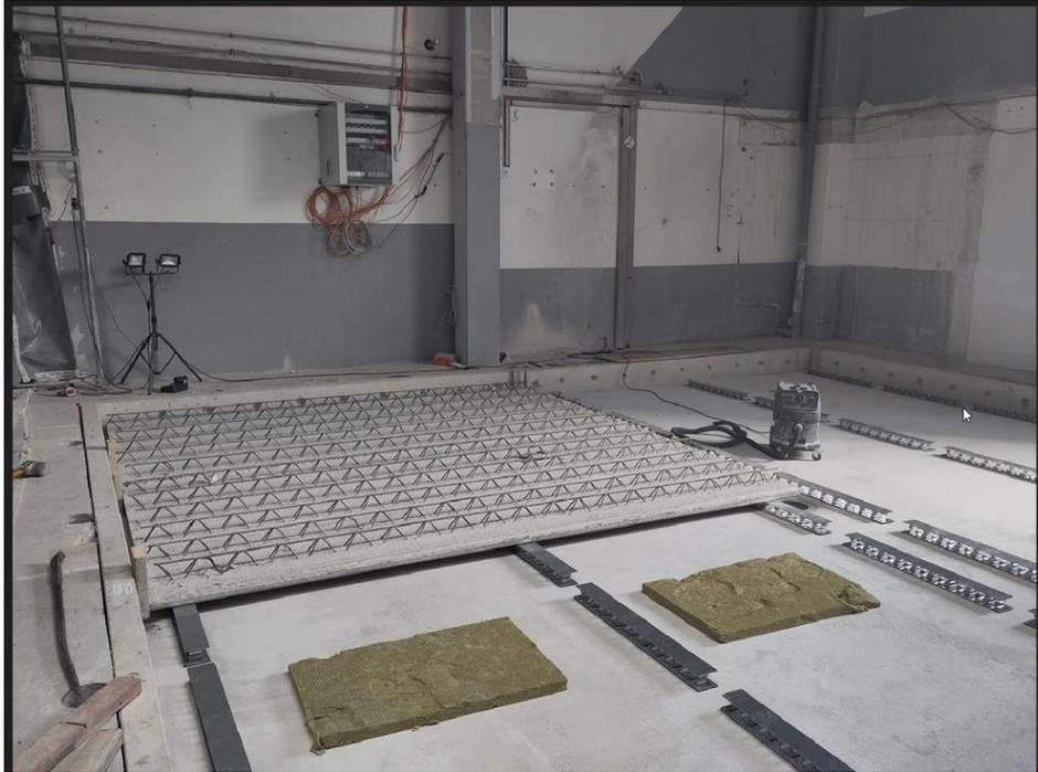
Entkoppelte Betonplatte für innere Kammer
