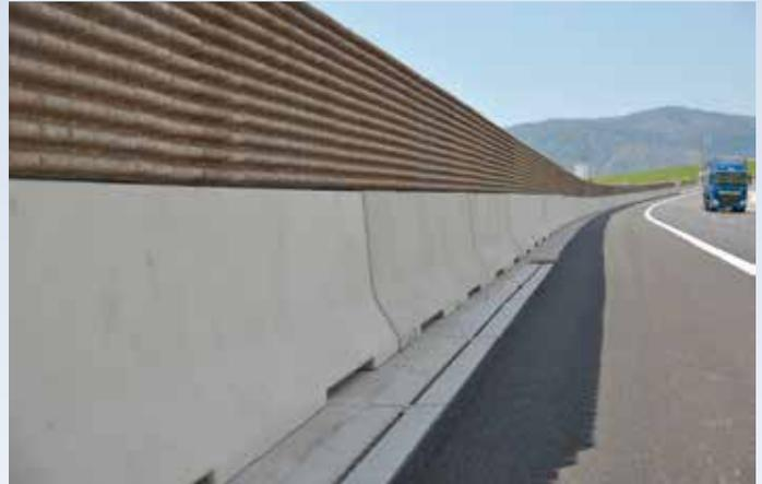
Die Fahrzeugrückhaltesysteme des österreichischen Herstellers sind nach DIN EN 1317 geprüft und durch die BAST begutachtet
