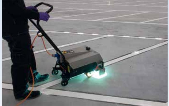
Das Markierungssystem UV-Line wird mit UV-Licht innerhalb von zwei Sekunden trocken und ist anschließend überfahrbar
