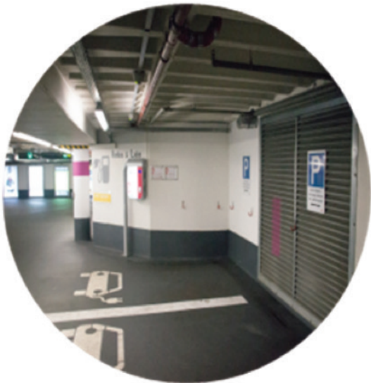
Figura 1 – Estação subterrânea de carregamento de veículos com robusto sistema de ventilação (Fonte: Zurich)
